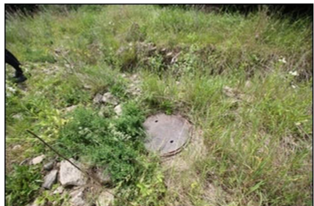
Abb.12 Ansicht Grundstück, Kanaldeckel
