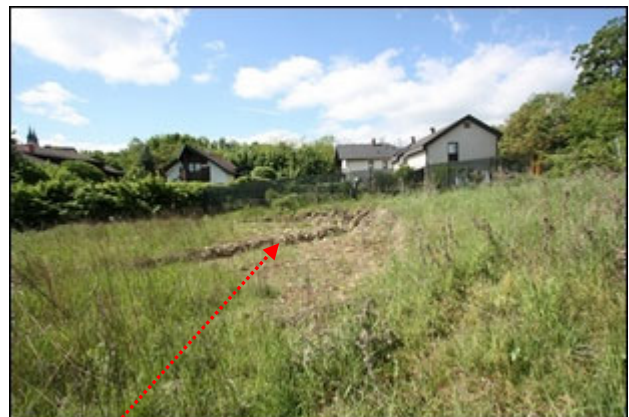
Abb.6 Ansicht Grundstück (Richtung Südwesten), offenbar iZm. der Bauvorbereitung angelegter Graben (Künette)
