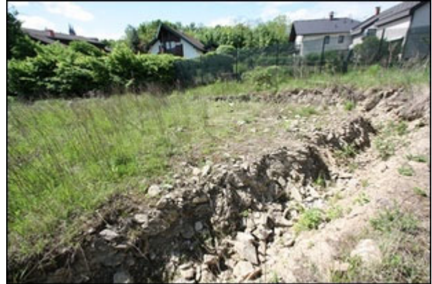
Abb.8 Ansicht Grundstück (Richtung Südwesten), offenbar iZm. der Bauvorbereitung angelegter Graben (Künette)
