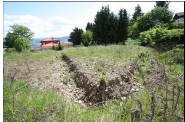
Abb.10 Ansicht Grundstück (Richtung Osten), offenbar iZm. der Bauvorbereitung angelegter Graben (Künette)
