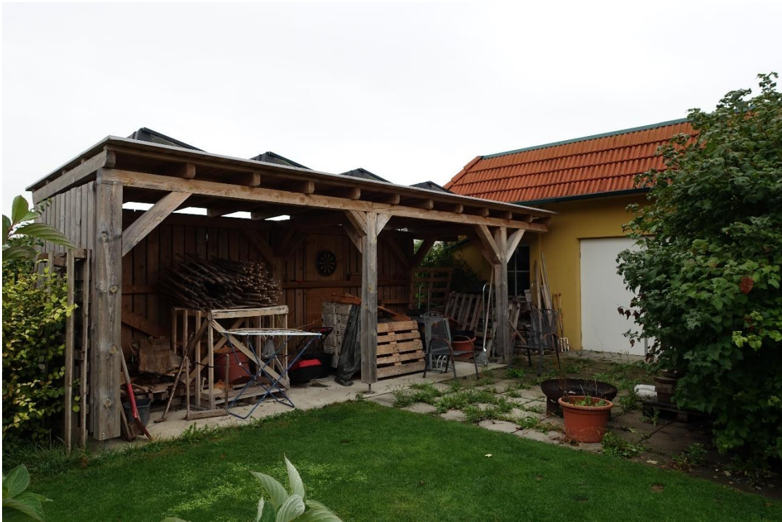
Foto 13 – Überdachung an ostseitiger Grundgrenze
