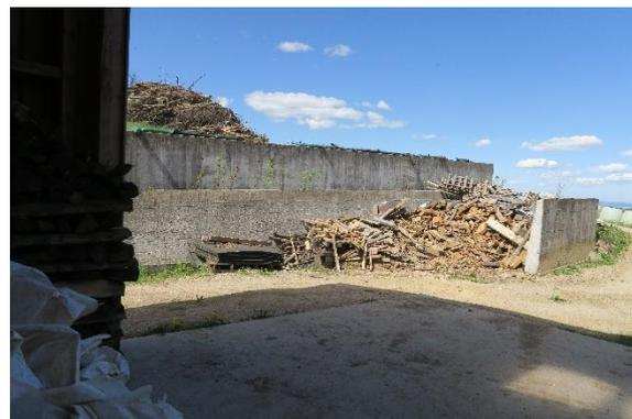
Dieser Fahrsilo wurde durch den Brand des Rinderstalles nahezu vollständig zerstört und ist nicht mehr nutzbar.
