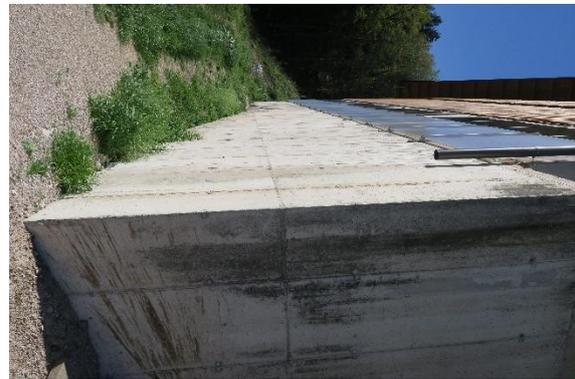
Im südöstlichen Bereich des Rinderstalles wurde die vorhandene Unebenheit des Geländes durch die Errichtung eines Güllekellers mit einem Fassungsvermögen von ca. 200 m<sup>3</sup> ausgeglichen.
