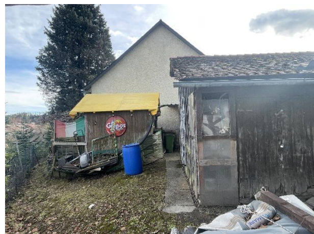
Abteil im Nebengebäude
