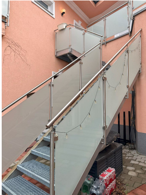
Foto 5: Stiegenaufgang zu den Wohnungen im Dachgeschoss
