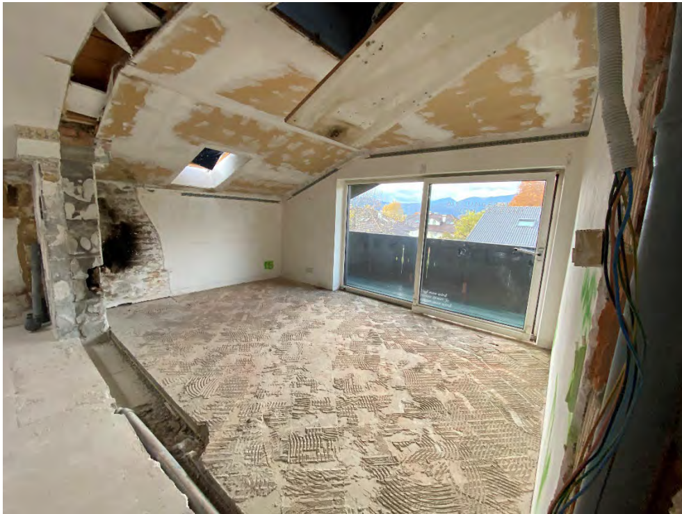
Dachgeschoss Wohnraum F5
