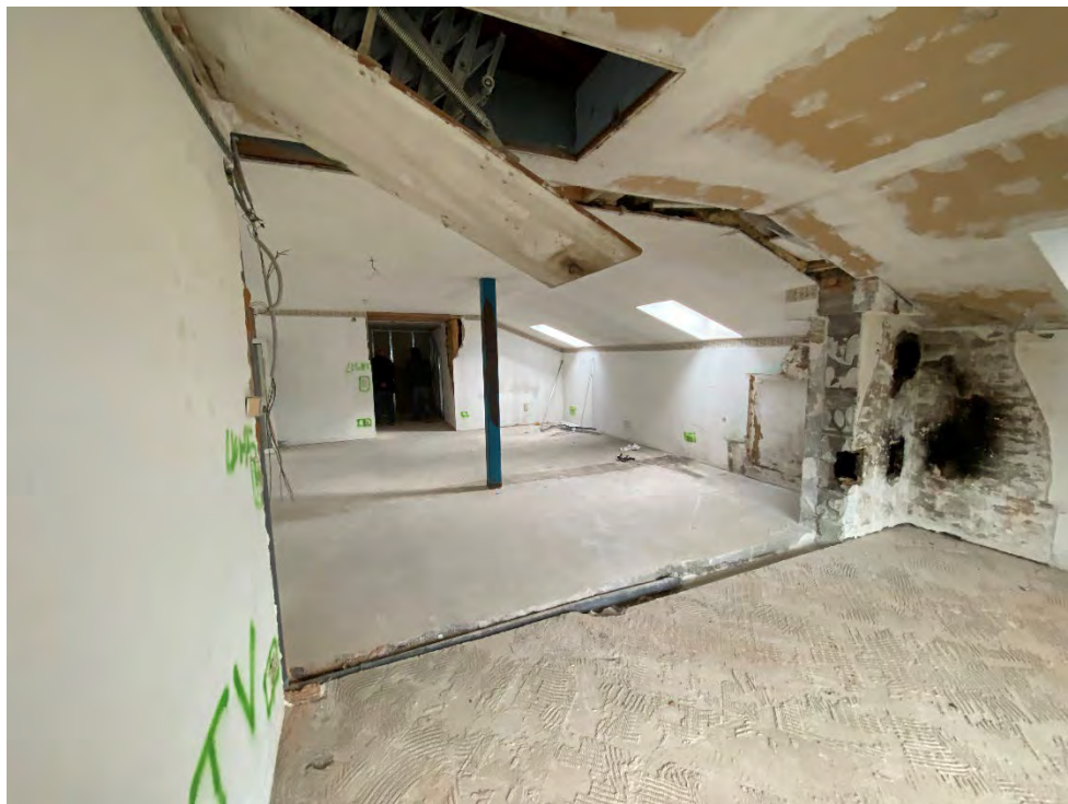
Dachgeschoss Wohnraum F4
