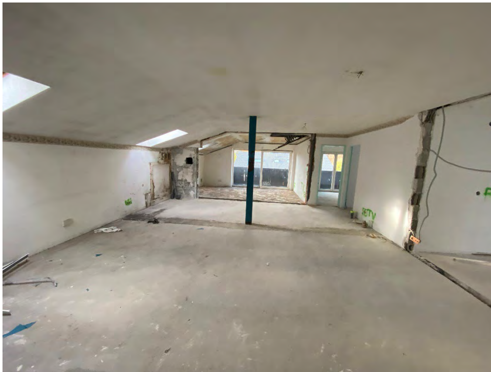
Dachgeschoss Wohnraum F1
