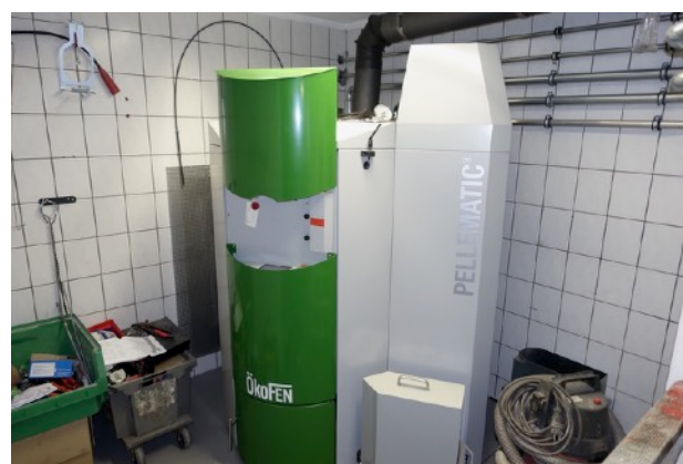
Heizraum - Pelletsheizung
