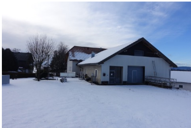
Ansicht von Norden
