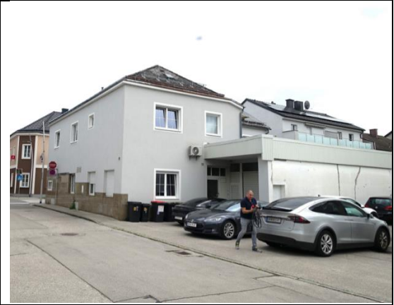
Wohn- und Geschäftshaus mit Einstellraum: Nordwestansicht
