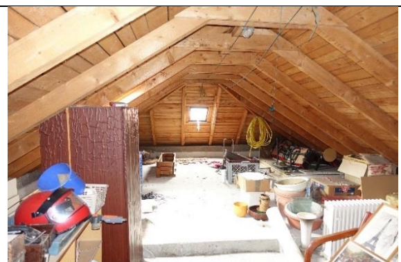
Dachboden: Boden: Beton; Dachschrägen: Holzsparren mit Brettverschlusschalung;
