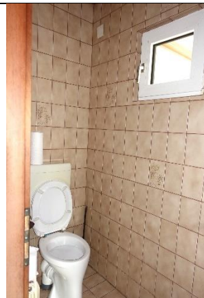
WC: Boden: Fliesen; Wände: Fliesen; Decke: Profilholzdecke; Sanitärausstattung: 1 Stand-WC mit Spülkasten, 1 elektrischer Abluftventilator;
