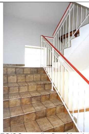
Treppe EG/OG: zweiläufige Massivtreppe mit Podest, jeweils mit Fliesenbelag; Metallgeländer mit Kunststoffhandlauf;
