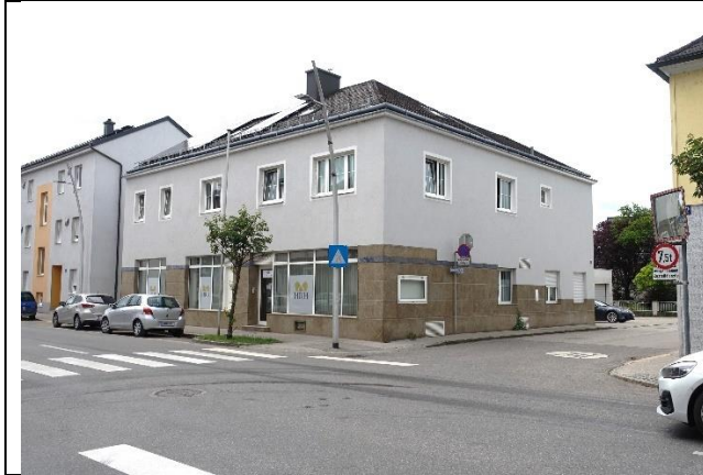
Wohn- und Geschäftshaus: Nordostansicht
