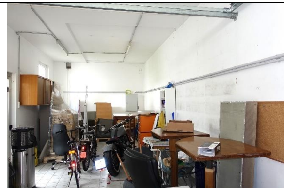
Einstellraum-Lager: Boden: Fliesen; Wände und Decke: verputzt und gemalt;
