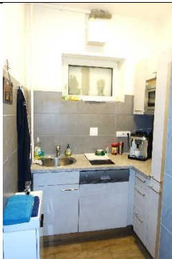
Teeküche: Boden: Fliesen; Wände: teilweise Fliesen, teilweise verputzt und gemalt; Decke: verputzt und gemalt; ZUBEHÖR: eine L-förmige Einbauküche mit Unter- und Oberschränken; Arbeitsplatten und Fronten beschichtet; Einbauten: 1 Edelstahlspüle mit Armatur, 1 Geschirrspüler, 1 Mikrowellenherd;
