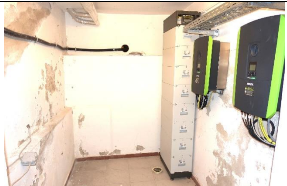
AR 1: Boden: Fliesen; Wände und Decke: verputzt und gemalt; erkennbare Feuchtigkeitsschäden im Boden-Wandbereich; 1 Batteriespeicher, Kapazität: ca. 22 kWh (Fabrikat BYD), 2 Wechselrichter (Fabrikat Kostal);
