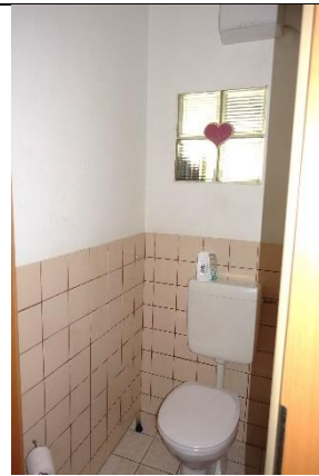
WC: Boden: Fliesen; Wände: teilweise Fliesen, teilweise verputzt und gemalt; Decke: verputzt und gemalt; Sanitärausstattung: 1 Stand-WC mit Spülkasten;
