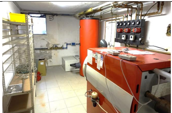
Heizraum: Boden: Fliesen; Wände und Decke: verputzt und gemalt; erkennbare Feuchtigkeitsschäden im Boden-Wandbereich; 1 Heizkessel mit Ölbrenner (Fabrikat Windhager, Bj 2004); 1 Warmwasserspeicher (ca. 200 l) beheizbar über den Heizkessel;
