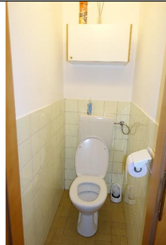
WC: Boden: Fliesen; Wände: teilweise Fliesen, teilweise verputzt und gemalt; Decke: verputzt und gemalt; Sanitärausstattung: 1 Stand-WC mit Spülkasten; 1 elektrischer Abluftventilator;
