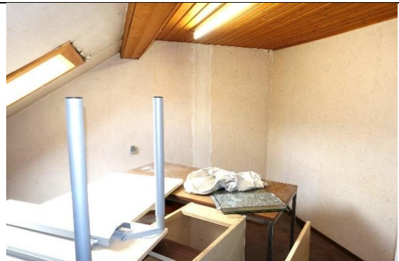
Abstellraum: Boden: Fliesen; Wände und Dachschräge: Tapeten; Decke: Profilholzdecke;
