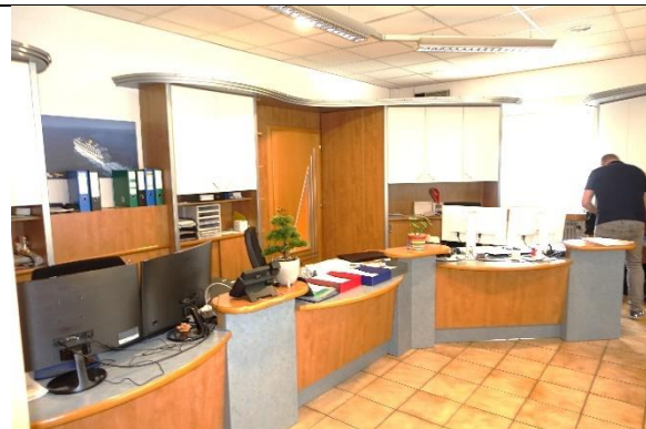
Kundenraum: Boden: Fliesen; Wände: Tapeten; Decke: abgehängte Elementdecke;
