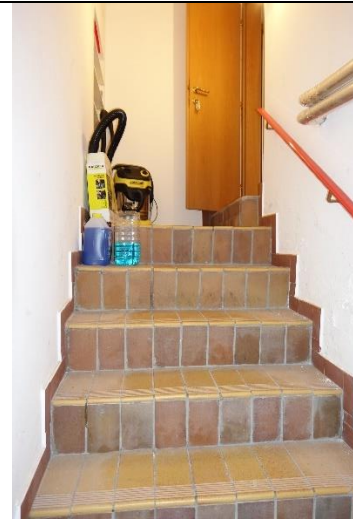
Treppe KG/EG: einläufige gerade Massivtreppe mit Fliesenbelag; Kunststoffhandlauf;
