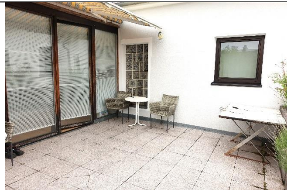
Terrasse: Boden: Waschbetonplatten; massive Brüstungswand;
