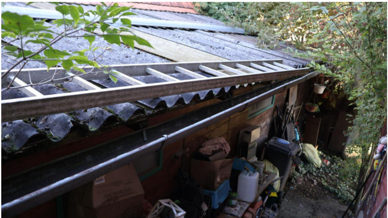
Gebäudeansicht Anbau Hofseite
