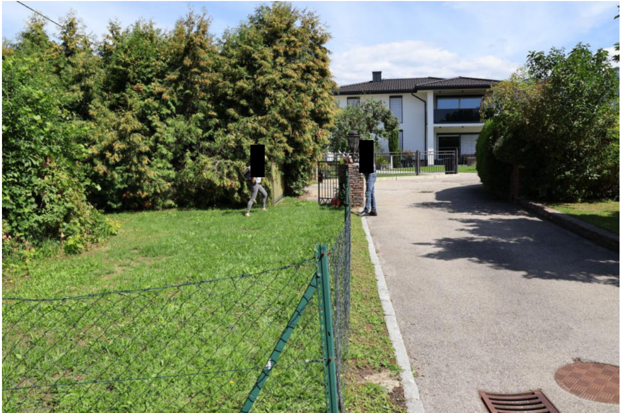
Maschengeflechteinfriedung mit überwuchernder Thujenhecke entlang der Nordseite
