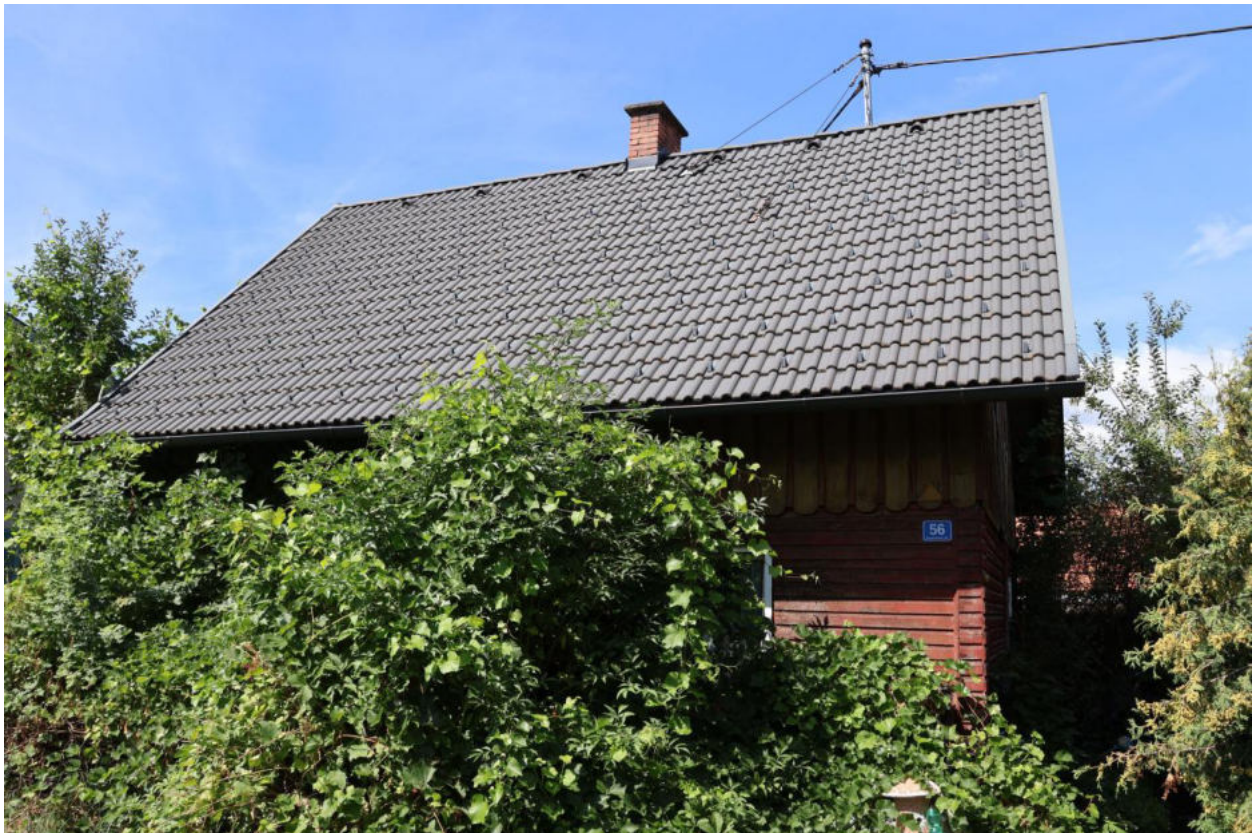
Gebäudeansicht von der Ostseite mit dem angeblich um das Jahr 2011 neu gedeckten Dach
