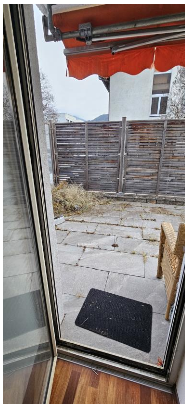
Abbildung 8 – Zugang Terrasse vom Wohnraum
