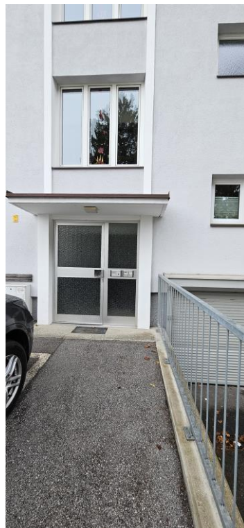
Abbildung 3 – Ansicht Ost Hauszugang
