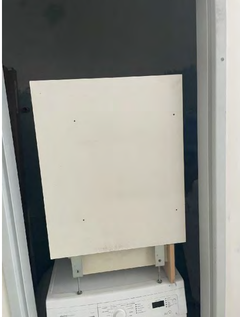
Bild 33 von 54 Blick in die nicht fertiggestellte Nasszelle im Zimmer 7
