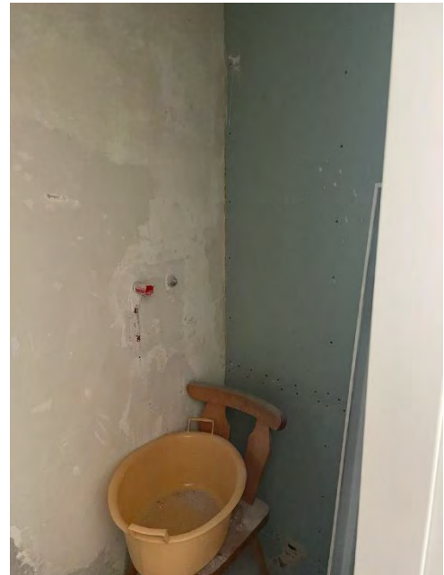
Bild 38 von 54 Blick in die nicht fertiggestellte Nasszelle im Zimmer 8
