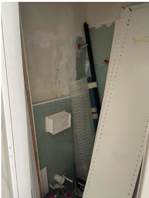
Bild 27 von 54 Blick in die nicht fertiggestellte Nasszelle im Zimmer 4
