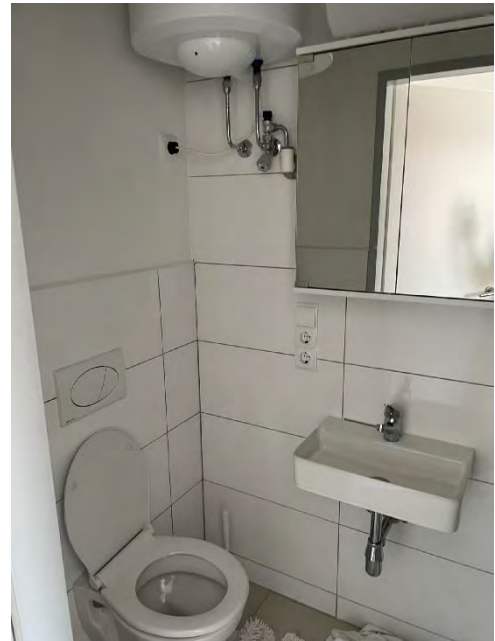
Bild 10 von 54 Blick in die Nasszelle im Zimmer 1
