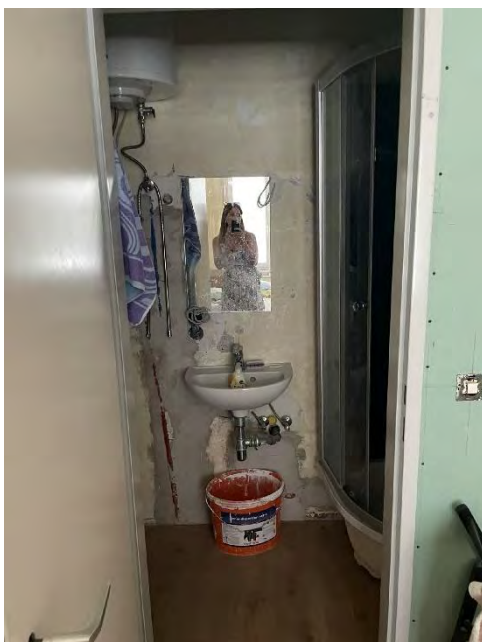
Bild 43 von 54 Blick in die Nasszelle im Zimmer 9
