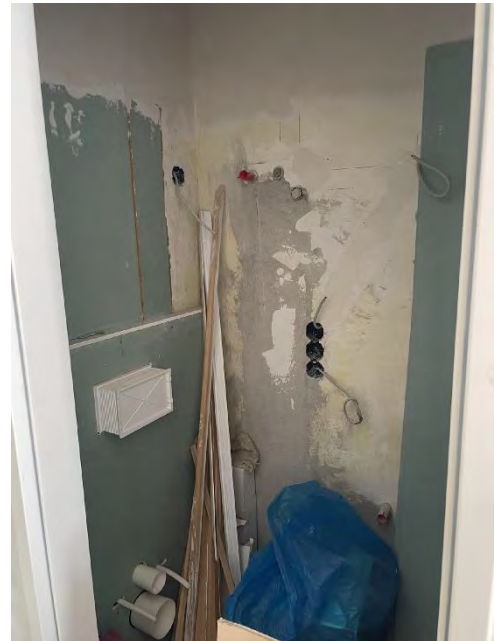
Bild 30 von 54 Blick in die nicht fertiggestellte Nasszelle im Zimmer 6
