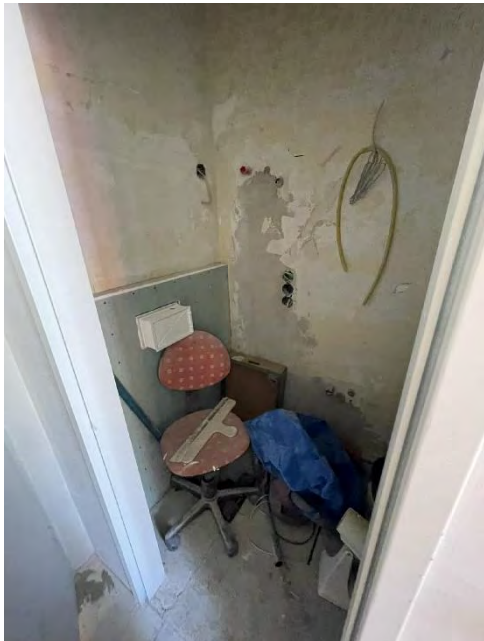
Bild 49 von 54 Blick in die nicht fertiggestellte Nasszelle im Zimmer 12
