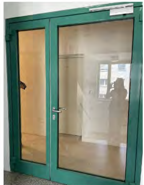
Bild 4 von 54 Blick auf die Eingangstüre zu Top 10
