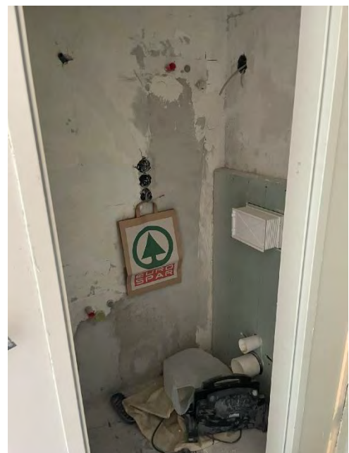
Bild 40 von 54 Blick in die nicht fertiggestellte Nasszelle im Zimmer 10
