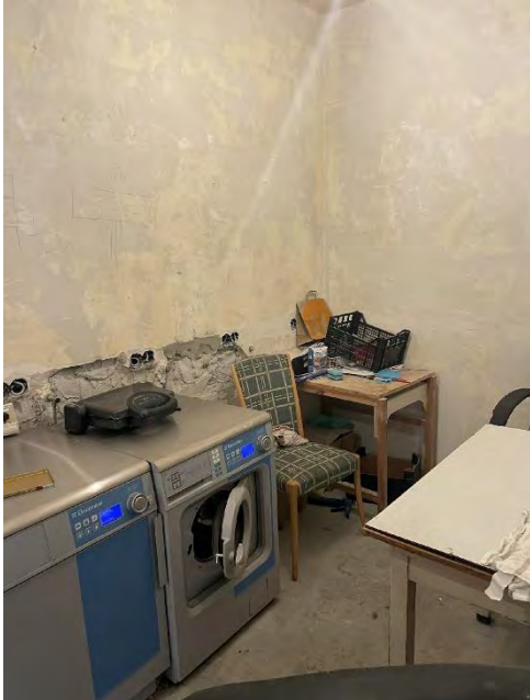
Bild 21 von 54 Blick in den vorderen Bereich des Zimmers 13
