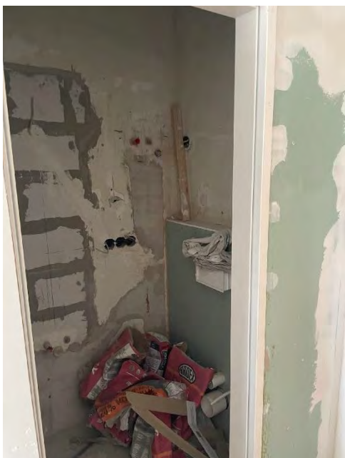
Bild 47 von 54 Blick in die nicht fertiggestellte Nasszelle im Zimmer 11
