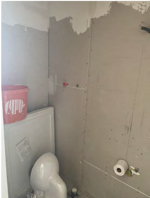
Bild 25 von 54 Blick in die nicht fertiggestellte Nasszelle im Zimmer 2
