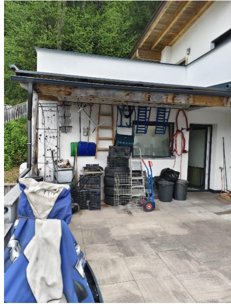
Abbildung 23: Ansicht Hintereingang Garage (2/8)
