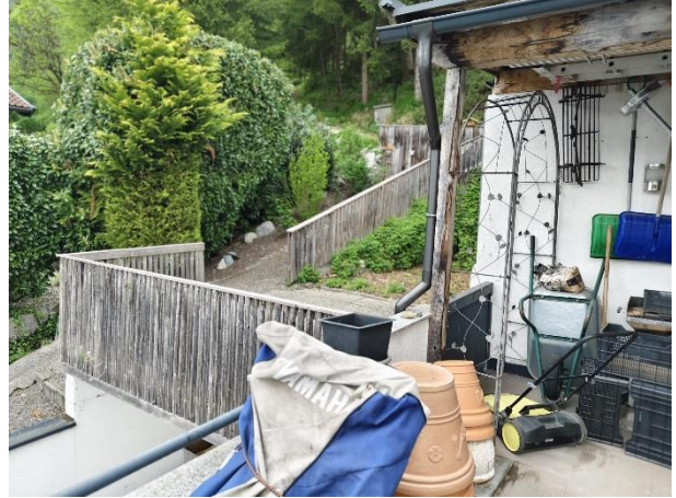
Abbildung 35: Terrasse rückwärtiger Bereich Richtung Garage (6/6)
