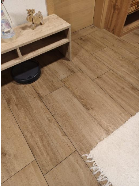
Abbildung 46: Flur, Details Bodenbelag (4/4)
