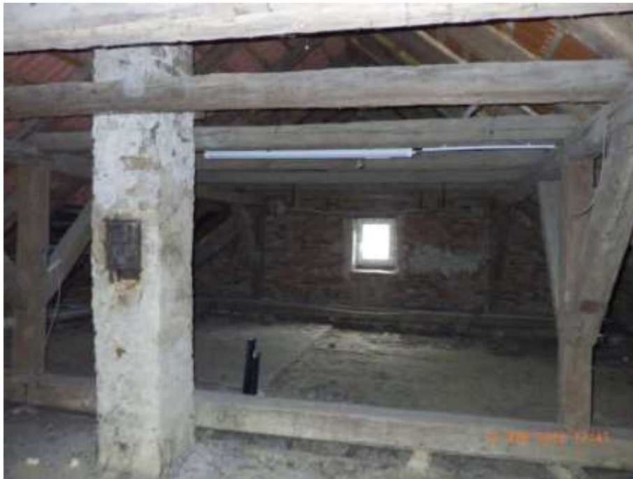
Dachbodenraum samt Stiege.
