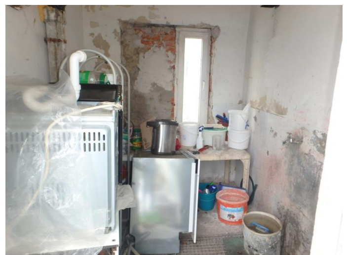
ehem. Waschküche im Erkervorbau
