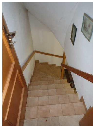
Stiegenanlage in das Kellergeschoß
