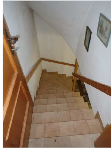
Provisorischer Handlauf in das Kellergeschoß
