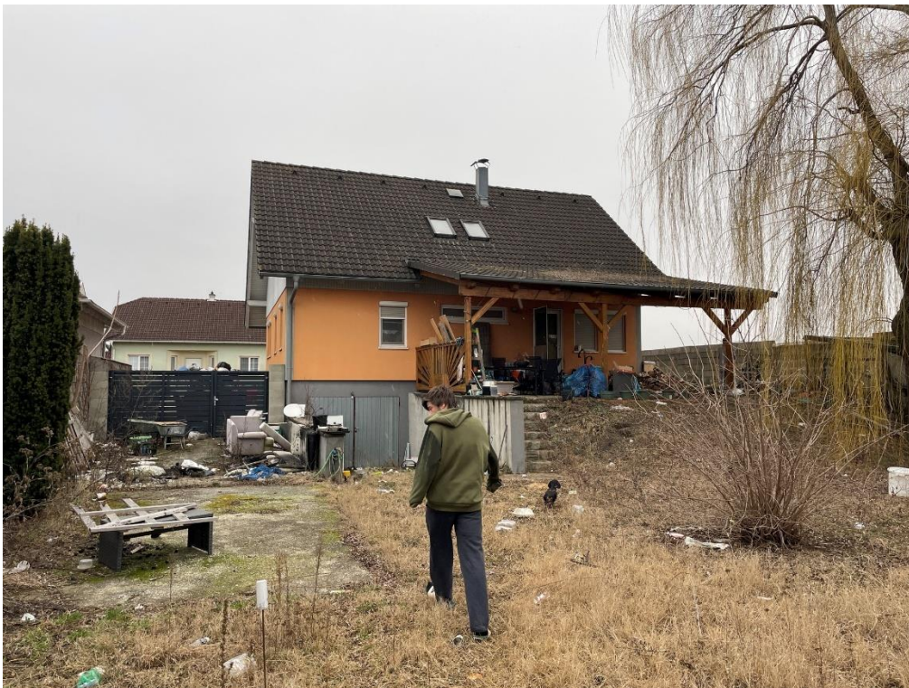
Blick auf Objekt zu Hoffassade
