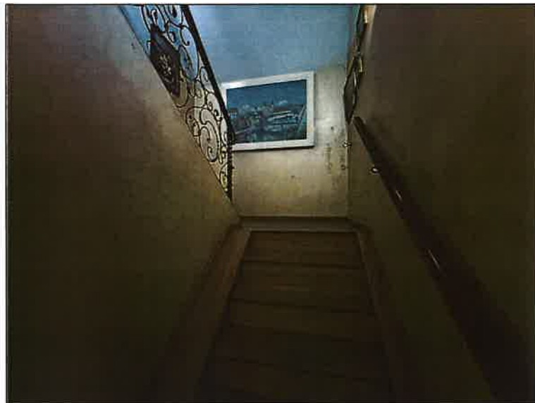
Über Holzstiege mit Setzstufen und Auftritten ins Obergeschoss OBERGESCHOSS
