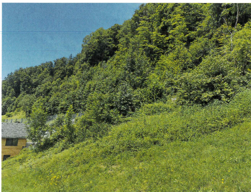
Quelle: Foto SV – Steinschlagschutznetz
