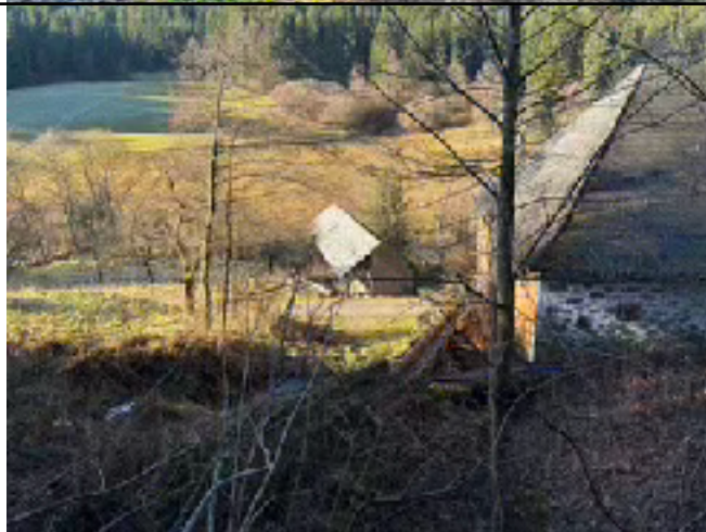
Nordansicht des Daches der Mühle im Hintergrund alte Venizianer Gattersäge
