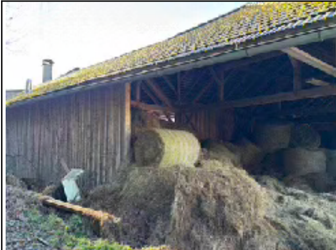
Heulager im OG des Wirtschafts- traktes Nordansicht
