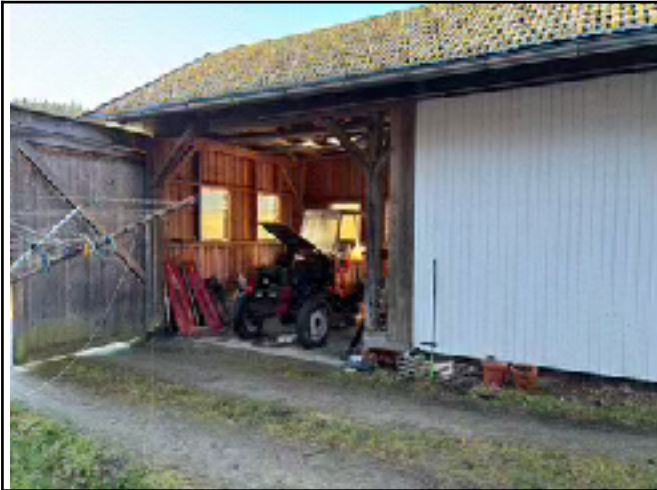
Hofansicht des Maschinenunterstandes
