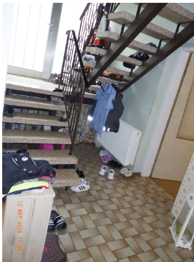
Vorraum und Gangfläche mit Stiege zum Dachboden
