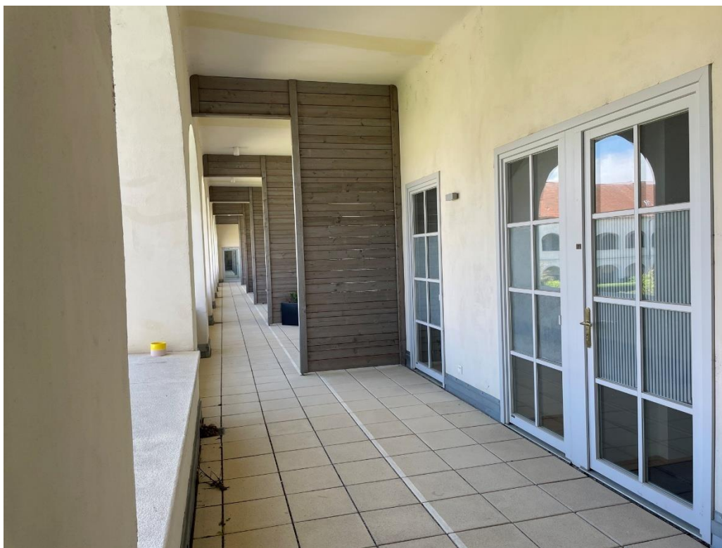
Blick auf zukünftige Laubengänge im Obergeschoss
