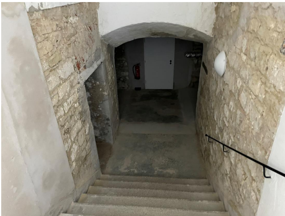
Blick auf Abgang zu Kellergeschoss
