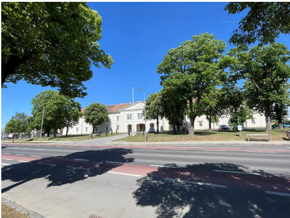
Blick auf Längsfassade Strassenseite mit Zugang zu Bauteil 5t
