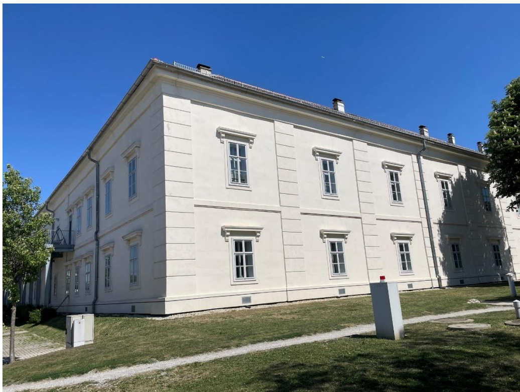
Blick auf Ecksituation BT 5 neben Durchfahrt im Erdgeschoss
