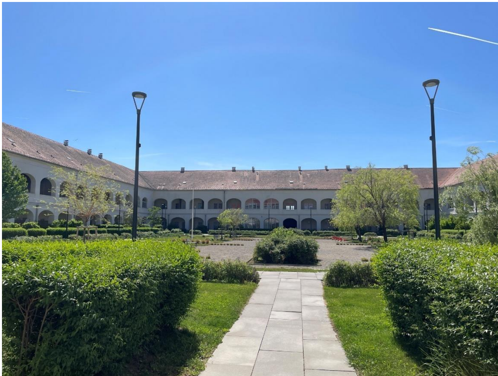
Blick auf gesamte Innenhoffassade BT 5
