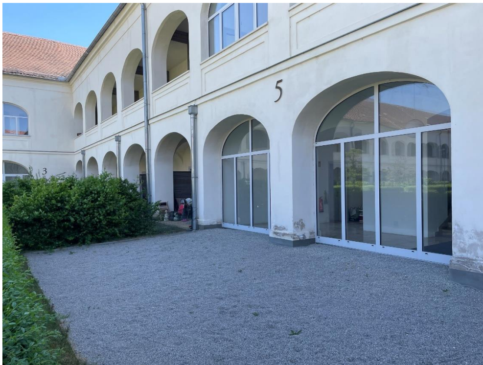
Blick auf Innenhoffassade BT 5
