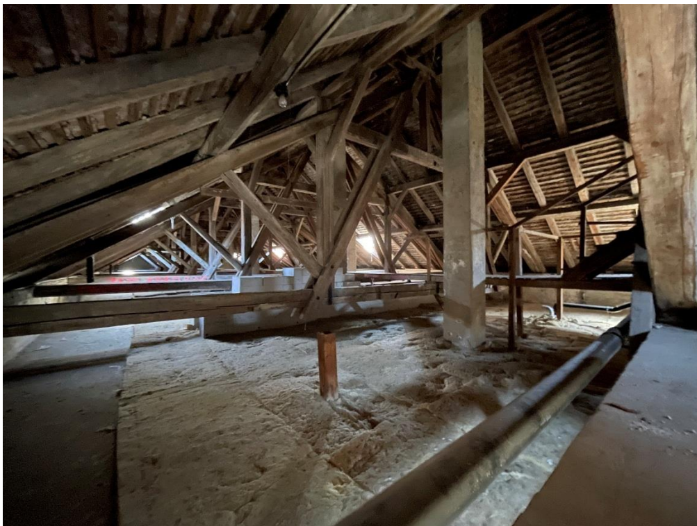
Blick auf unausgebauten Dachstuhl im Dachgeschoss
