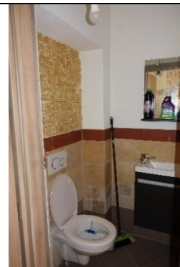
WC-EG: Boden: Natursteinplatten; Wände: teilw. Natursteinplatten, teilw. verputzt und gemalt; Decke: verputzt und gemalt; Sanitärausstattung: 1 Handwaschbecken mit Unterschrank, 1 Hänge-WC mit Unterflurspülkasten;
