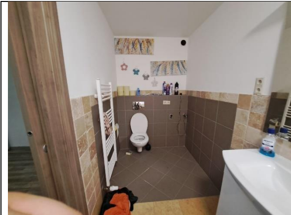
Bad-EG: Boden: teilw. Natursteinplatten, teilw. Fliesen; Wände: teilw. Natursteinplatten, teilw. Fliesen, teilw. verputzt und gemalt; Decke: verputzt und gemalt;
