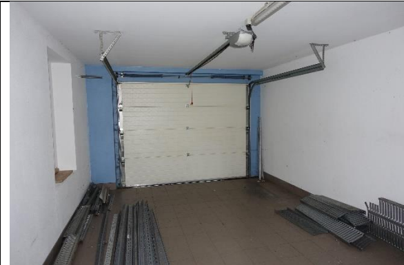
Garage 4: Boden: Fliesen; Wände und Decke: verputzt und gemalt; 1 Deckensektionaltor mit elektrischem Antrieb und Funkfernsteuerung;
