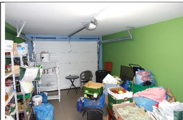
Garage 3: Boden: Fliesen; Wände und Decke: verputzt und gemalt; 1 Deckensektionaltor mit elektrischem Antrieb und Funkfernsteuerung;
