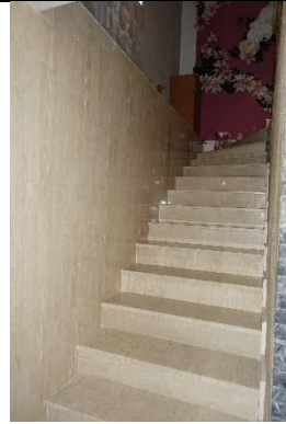
Treppe EG/OG: gefächerte Massivtreppe mit Natursteinbelag;
