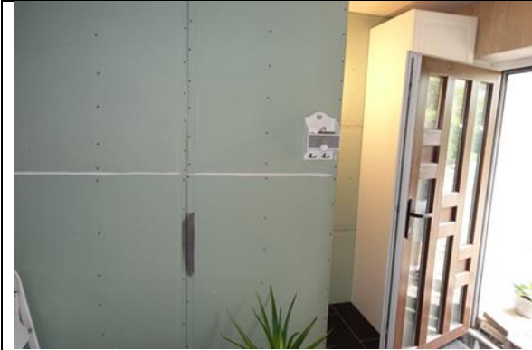
Windfang-EG/OG: Boden: Natursteinplatten; Wände: teilw. verputzt und gemalt, teilw. Gipskartonplatten ungespachtelt; Decke: verputzt und gemalt;
