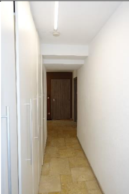
Vorraum-EG: Boden: Natursteinplatten; Wände und Decke: verputzt und gemalt;
