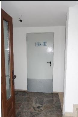
Windfang-EG: Boden: Natursteinplatten; Wände und Decke: verputzt und gemalt;
