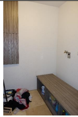
Abstellraum-OG: Boden: Natursteinplatten; Wände und Decke: verputzt und gemalt; 1 Waschmaschinenanschluss;
