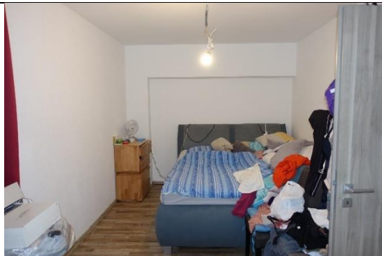
Schlafzimmer-OG: Boden: Laminatboden; Wände und Decke: verputzt und gemalt;
