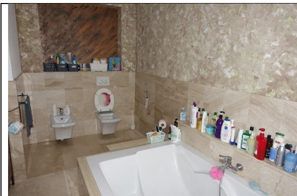
Bad-OG: Boden: Natursteinplatten; Wände: teilw. Natursteinplatten, teilw. verputzt und gemalt; Decke: verputzt und gemalt;
