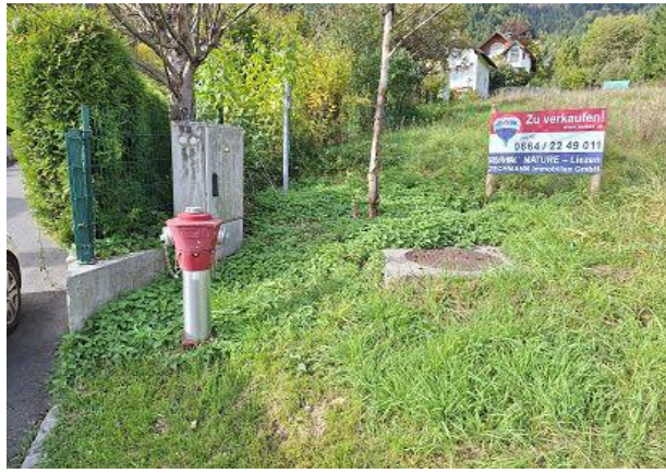
Abbildung 11: Schachtbauwerk, vermutlich für die Wasserversorgung der Stadtgemeinde Liezen
