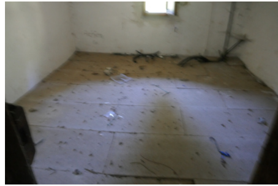
Porenverschluss Platten im Dachboden
