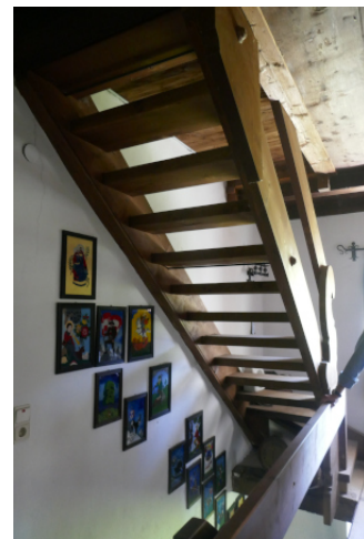
Treppe im Obergeschoss-
