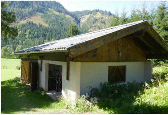
Nebengebäude von der Ostseite
