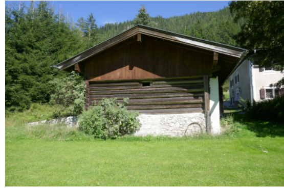
Ansicht Nebengebäude von Westen
