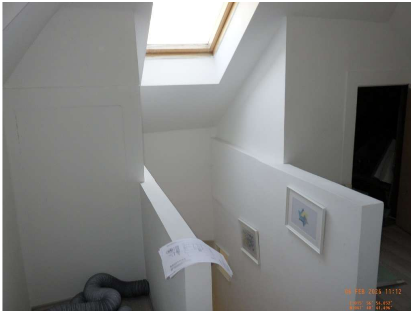
Vorraum bei der Stiege
