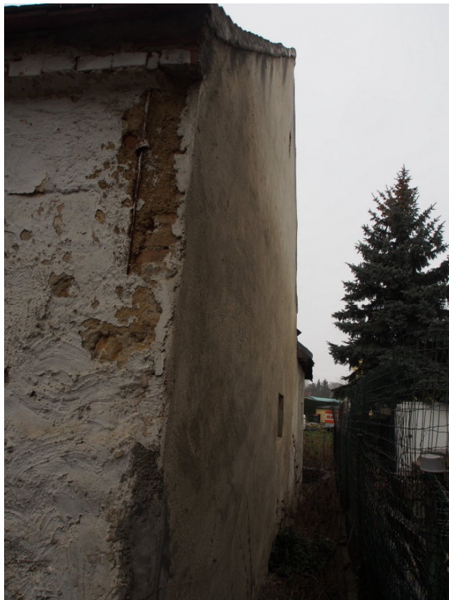
Foto 24 Nordansicht Wirtschaftsgebäude - Stadl
