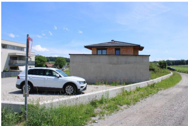
Ansicht von Norden mit Mauer gegen Hangwasser
