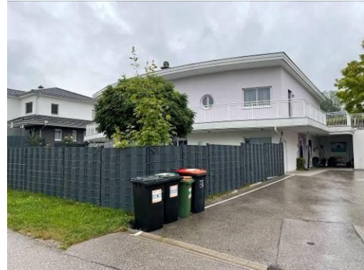
Südostansicht des Wohnhauses
