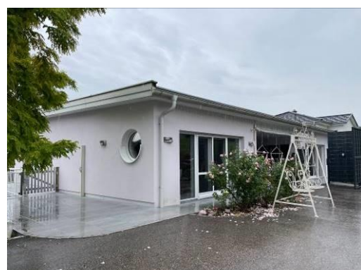
Nordostansicht des Wohnhauses (OG)
