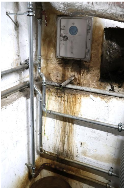
Kaminsanierung mit Abgasfanganschluss
