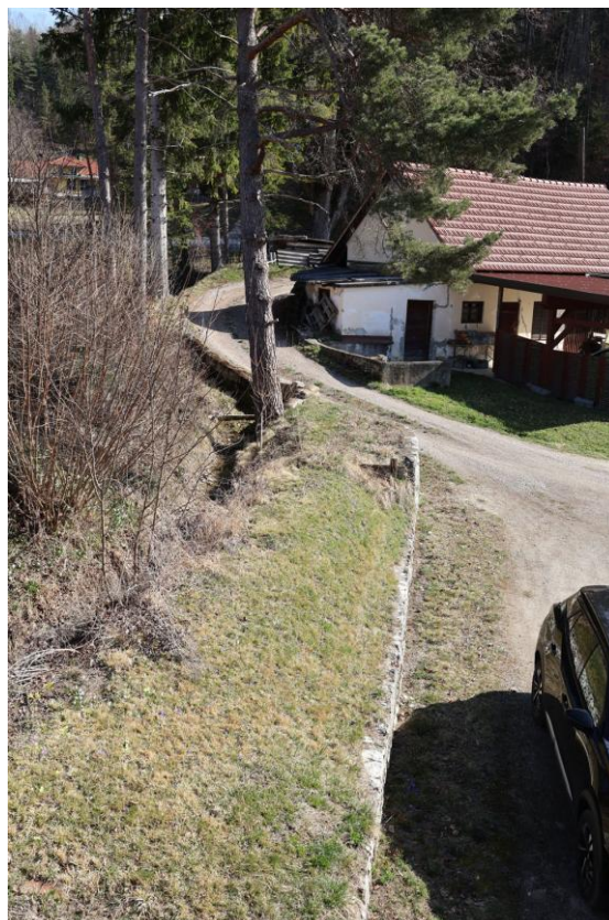
Zufahrtsweg entlang vom Kleinzapfner Bach
