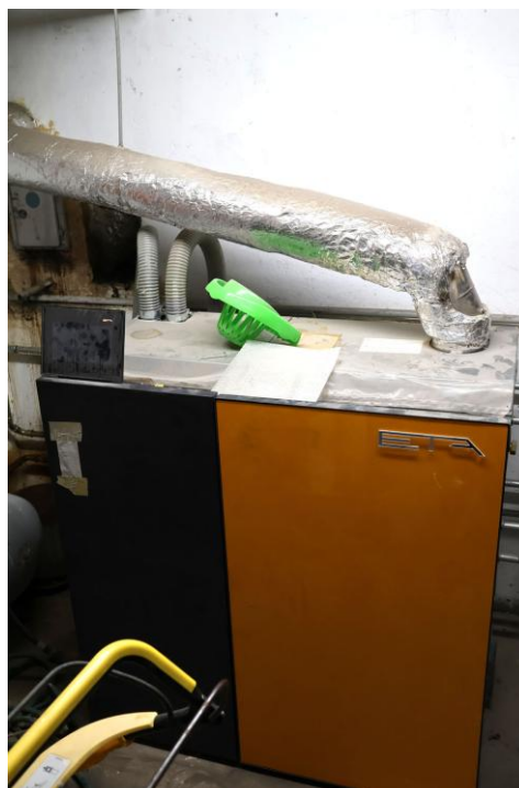
Pelletsheizkessel
