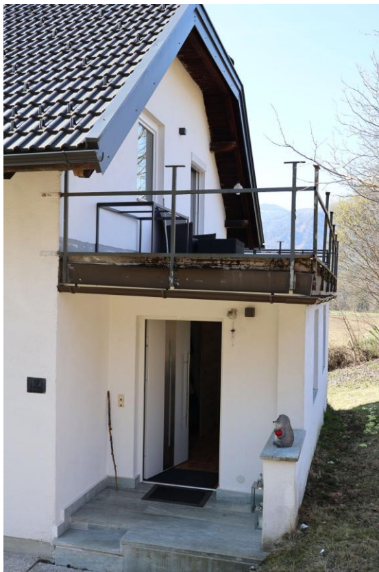
Hauseingang mit WF-Zubau und Flachdachausbildung an der Westseite
