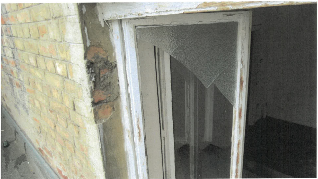
Mauerwerksschäden, kaputte Fensterschreiben (exemplarisch)
