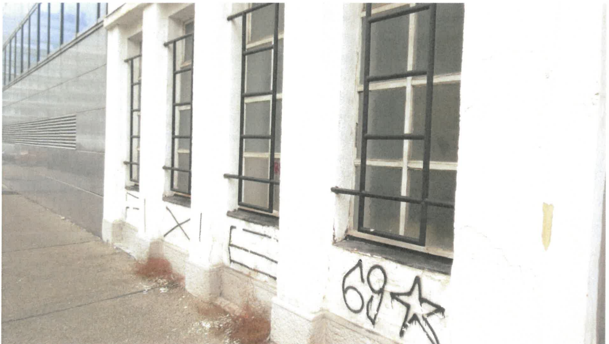
Fassade straßenseitig (Putzschäden exemplarisch)
