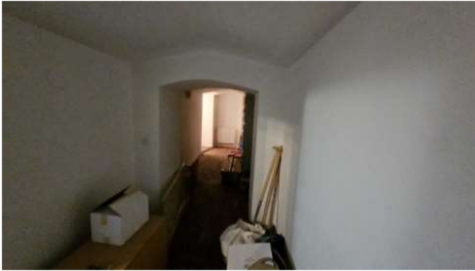
Abstellraum: Boden mit Platten bedeckt, Wände und Decke gestrichen
