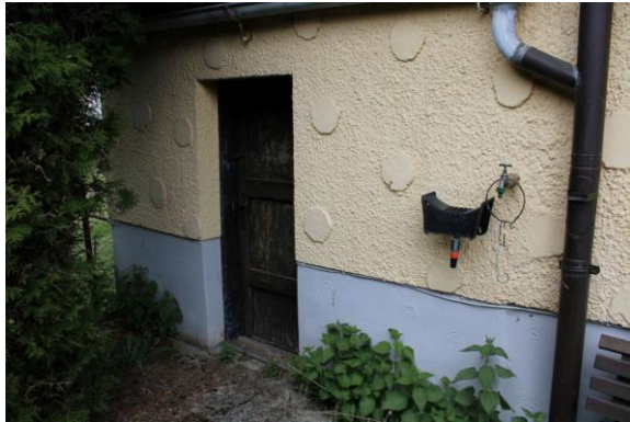
Bild 7: Zugang Abstellraum Südwestseite
