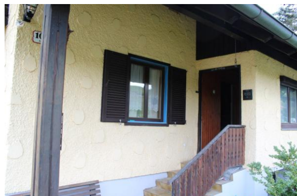
Bild 12: Windfang – Eingang Wohnhaus
