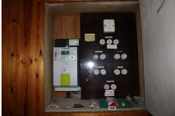
Bild 31: Sicherungskasten
