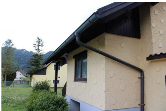
Bild 11: Windfang – Anbau Nordostseite
