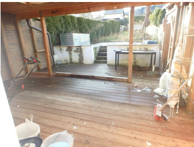
Terrasse / ehem. Wintergarten
