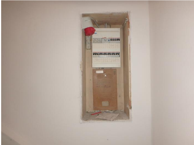
Sicherungskasten
