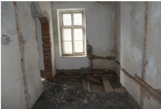
Innenansicht rückgebaute Wohnung
