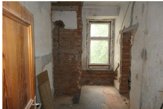
Innenansicht rückgebaute Wohnung
