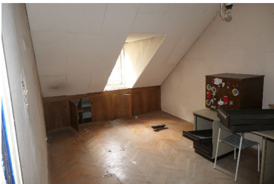
Innenansicht ausgebauter Dachboden
