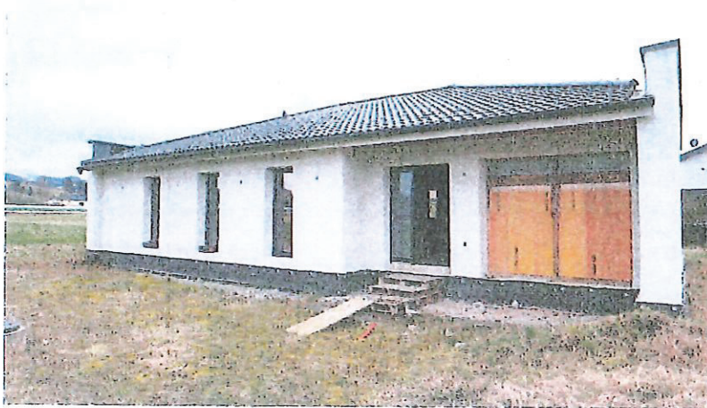
Gebäudeansicht v. Norden, Vorplatz Zugang
