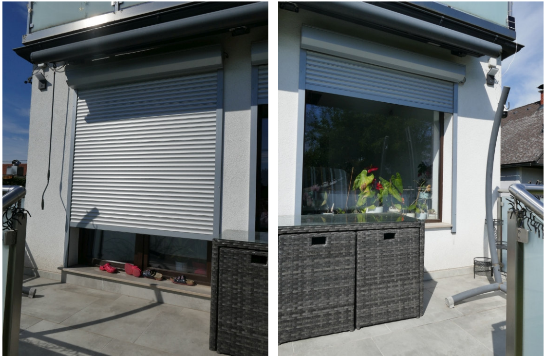
Terrasse östlich an Esszimmer anschließend
