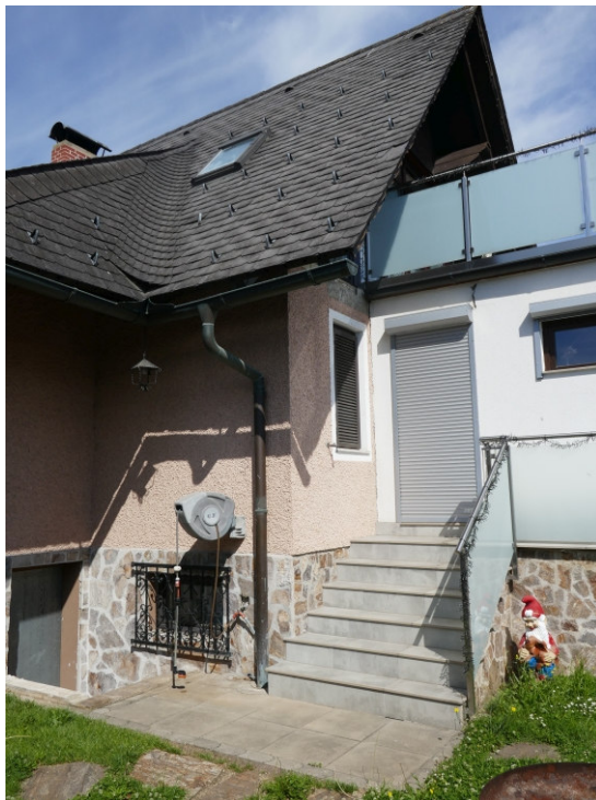
Ansicht Fassade Südseite
