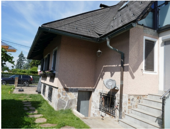
Treppenabgang Keller und südseitige Treppe zu Terrasse
