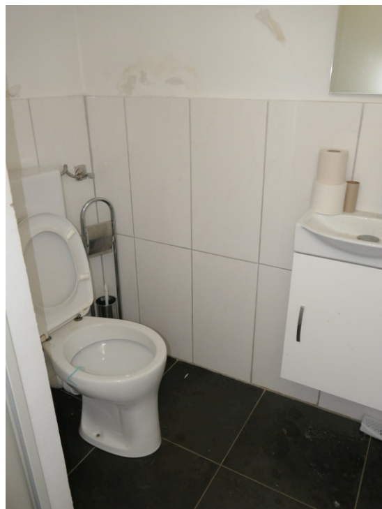
WC im Keller
