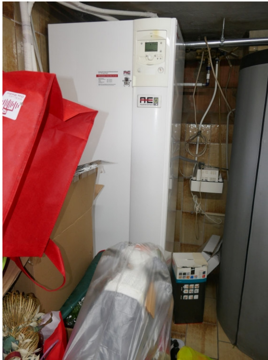
Heizung (Luftwärmepumpe)
