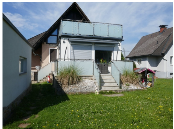
Ostseitiger Zugang zu Terrasse
