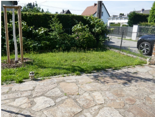
Befestigung und Garten auf Südseite Wohnhaus
