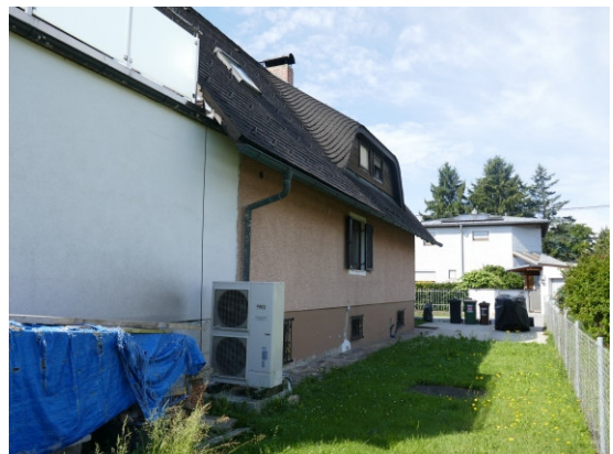
Ansicht Fassade Nordseite
