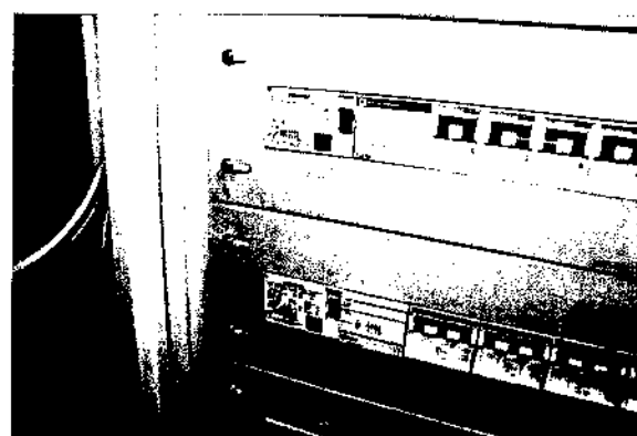
Abb. 63 Zentrale Notbeleuchtung
