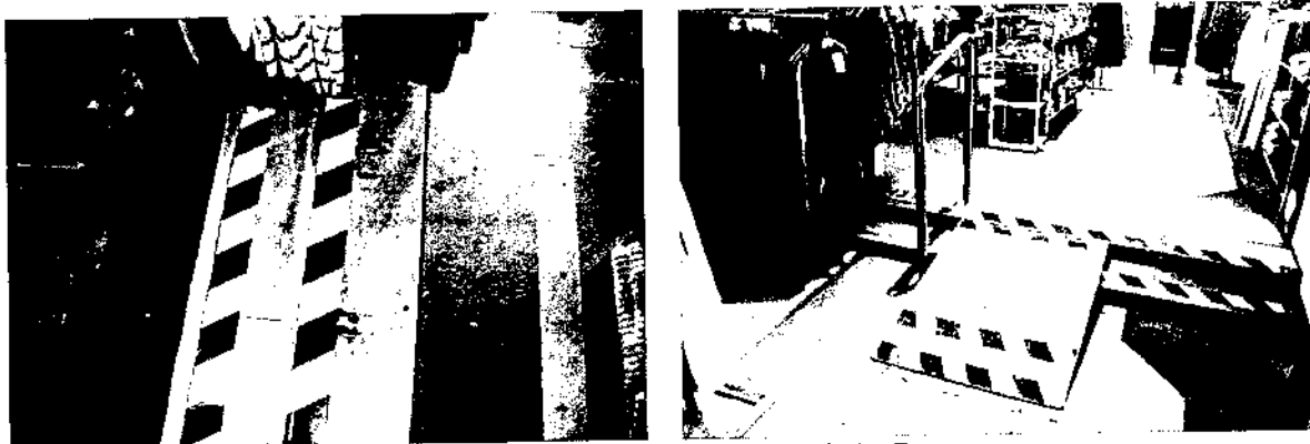
Abb. 42 Nachträglich eingebaute provisorische Rampe
