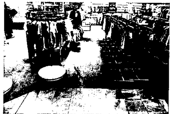
Abb. 5 Wasserspuren Textilbelag
