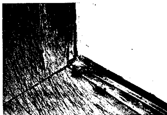
Abb. 44 Schadhafte, stark abgenutzte Bodenbeläge
