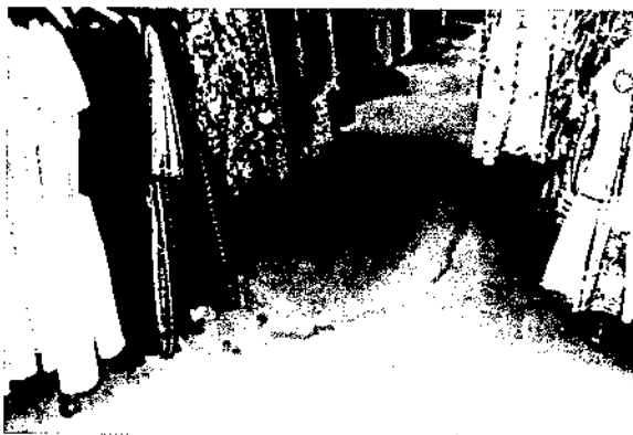
Abb. 5 Wasserspuren Textilbelag
