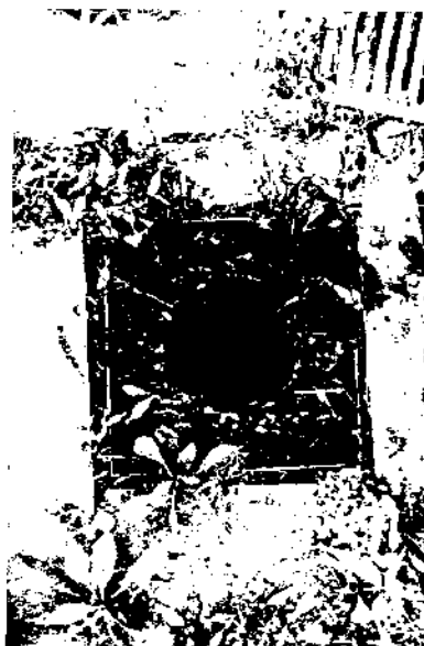
Abb. 11 Verschmutzter Ablauf
