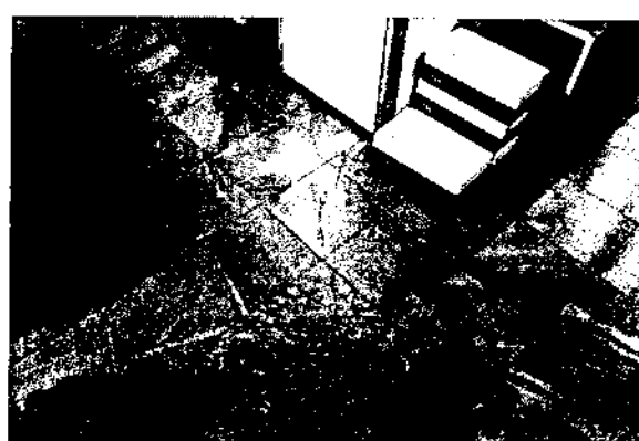
Abb. 43 Abgenutzte Treppe, Schäden
