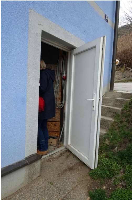
EINGANG HOLZL./HEIZRAUM - FOTO 32
