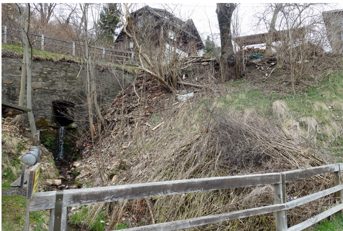
NORDWESTLICHE BÖSCHUNGSFLÄCHE - FOTO 84
