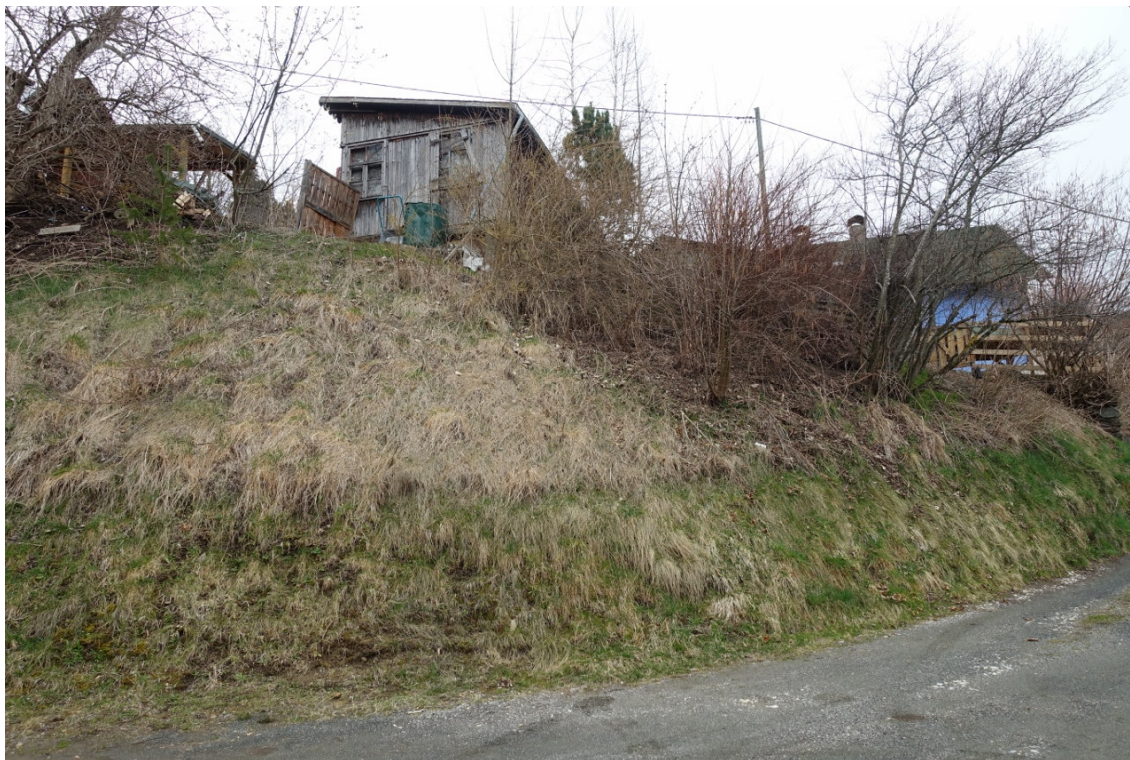
NORDWESTLICHE BÖSCHUNGSFLÄCHE - FOTO 83
