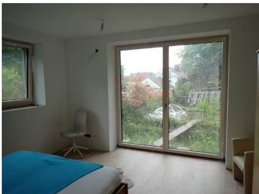
Beleuchtungskörper fehlend, Elektroinstallation nicht fertig gestellt, Sockelleisten fehlend
