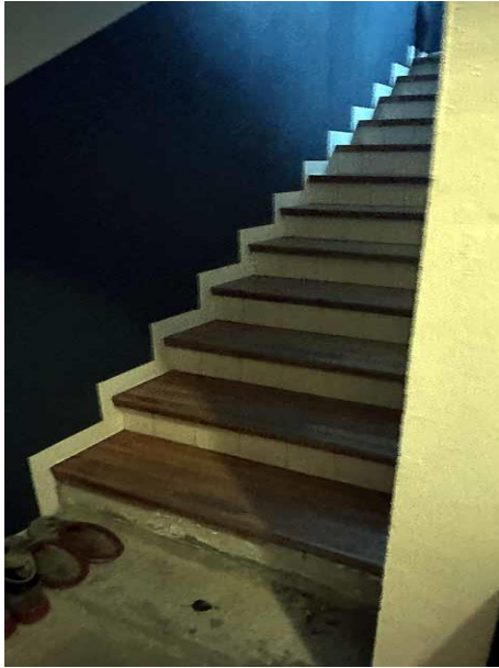
Treppe EG ins OG (ohne Handlauf)
