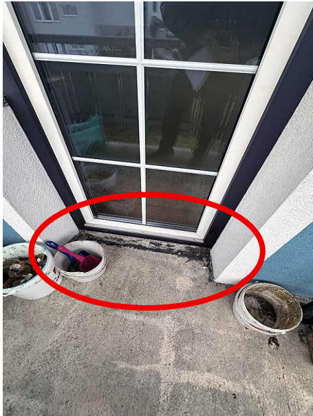
Fehlende Abdichtung an Balkontüre im OG
