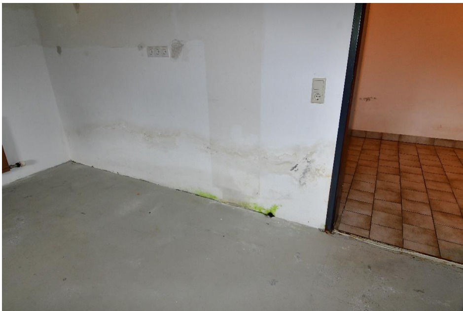
Bild 18 Kellergeschoss Feuchtigkeitshochzüge
