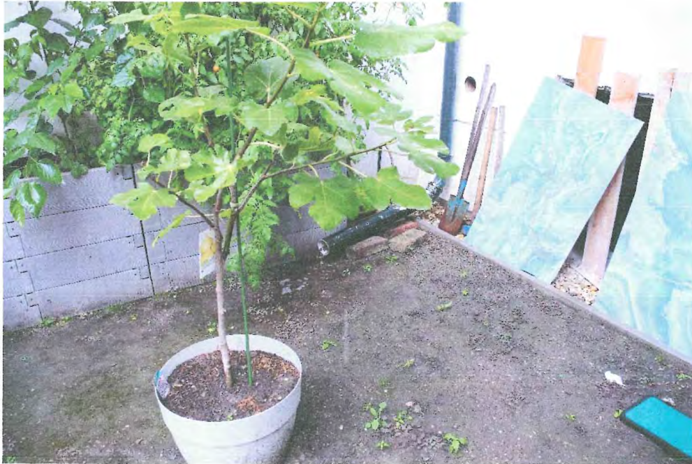
Abbildung 68: Dachentwässerung frei im Innenhof (TOP 9) auslaufend
