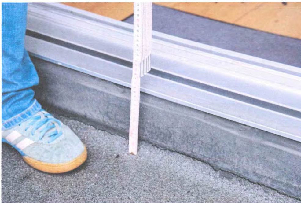
Abbildung 7: Terrassenaustritt aus Top 34 (von innen „rechts“)
