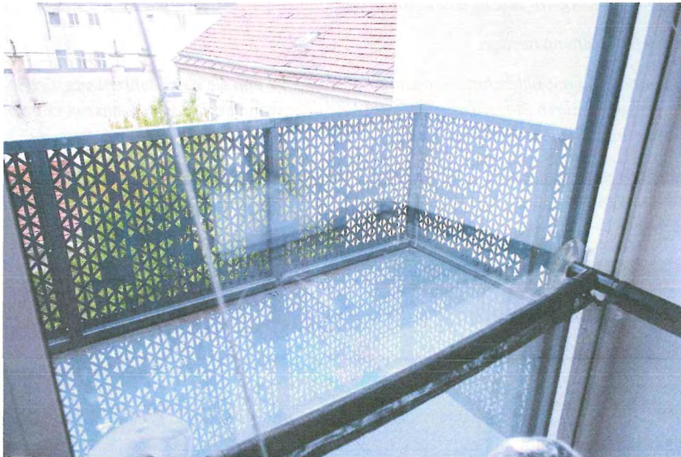
Abbildung 70: Balkonkonstruktion, mit Stahlplatten
