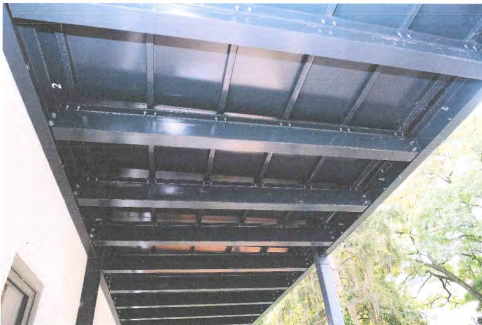
Abbildung 69: Untersicht aufgeständerte Balkone
