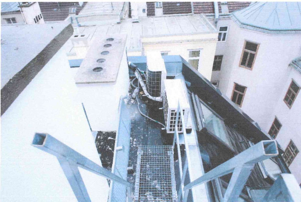
Abbildung 10: Wartungsteg am Dach
