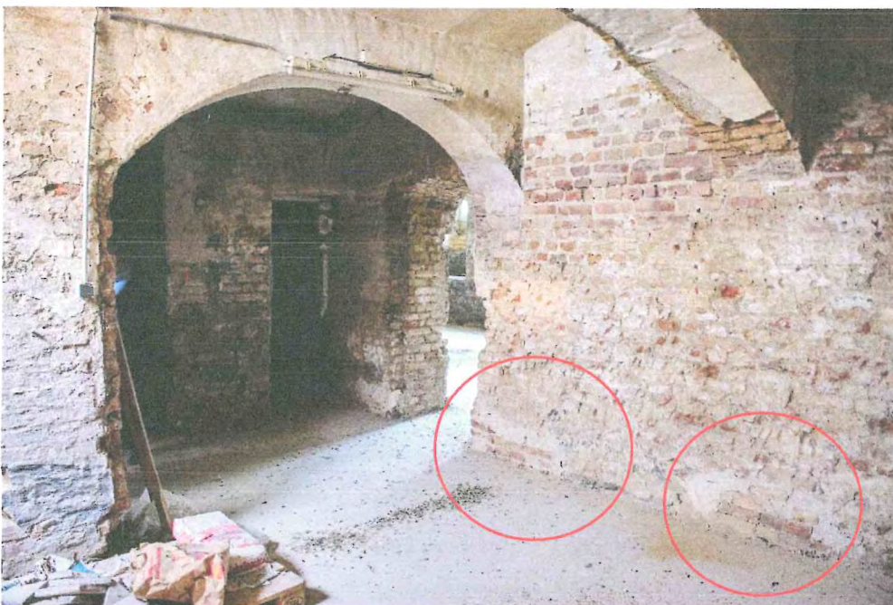
Abbildung 50: Kellerraum mit Bodenplatte und ausgemauerten Nischen
