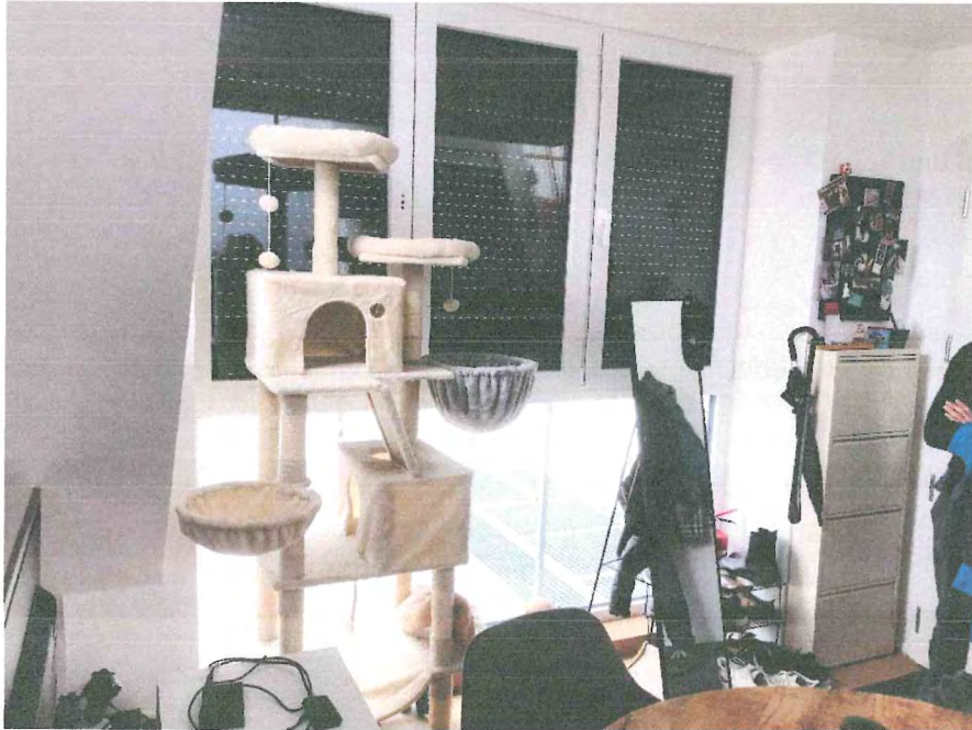
Abbildung 42: Zustieg zu 2. Rettungsweg durchs Fenster, TOP 36 (keine Fluchtwegetür, Rettungsweg durch Fensteröffnung)
