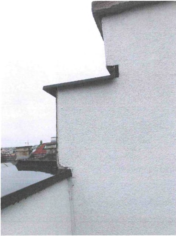
Abbildung 28: Anschlüsse mangelhaft
