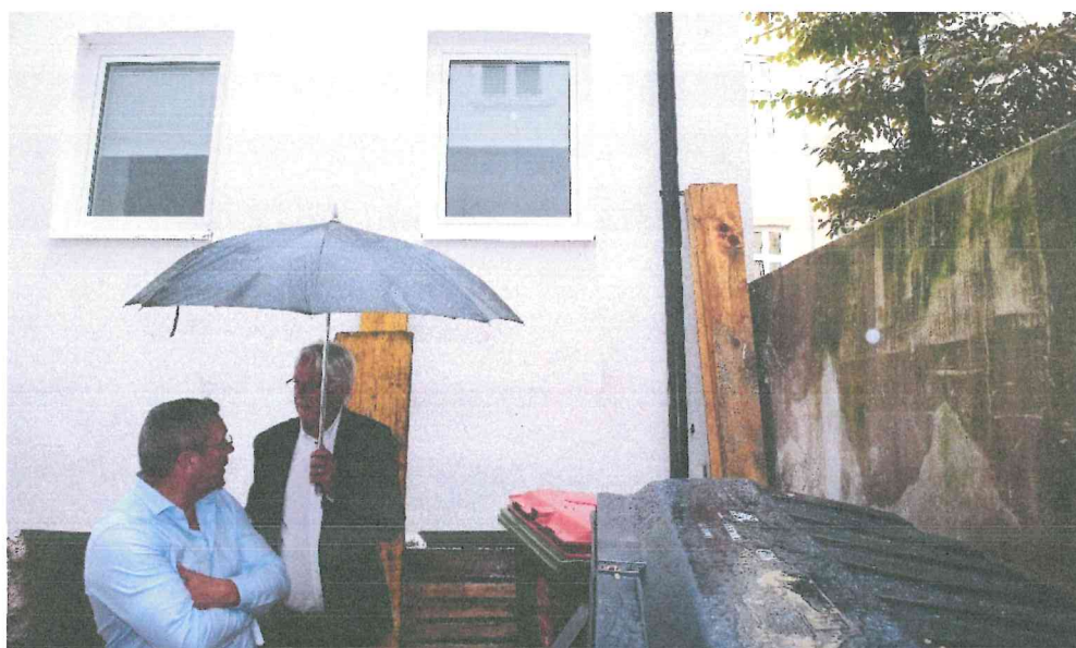
Abbildung 23: Fassade Innenhof vor TOP1, Einbindung Mauer zum Nachbarn
