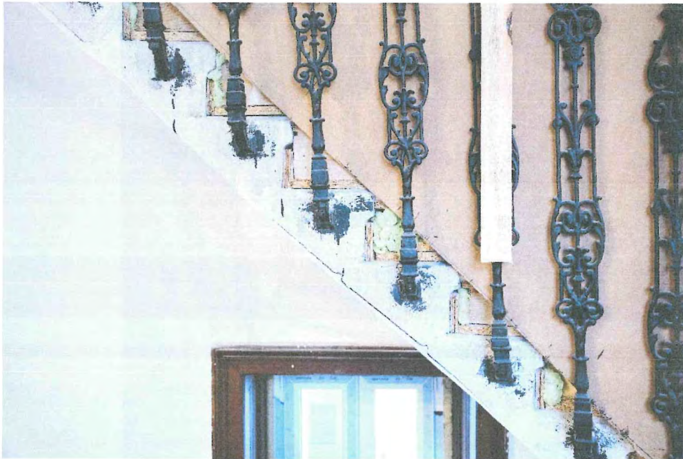
Abbildung 32: Treppenlauf und Geländer zwischen 3.OG und 1. DG
