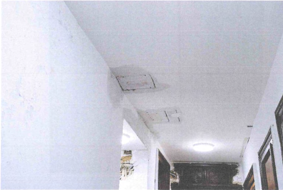
Abbildung 34: Deckenöffnungen im 3. OG
