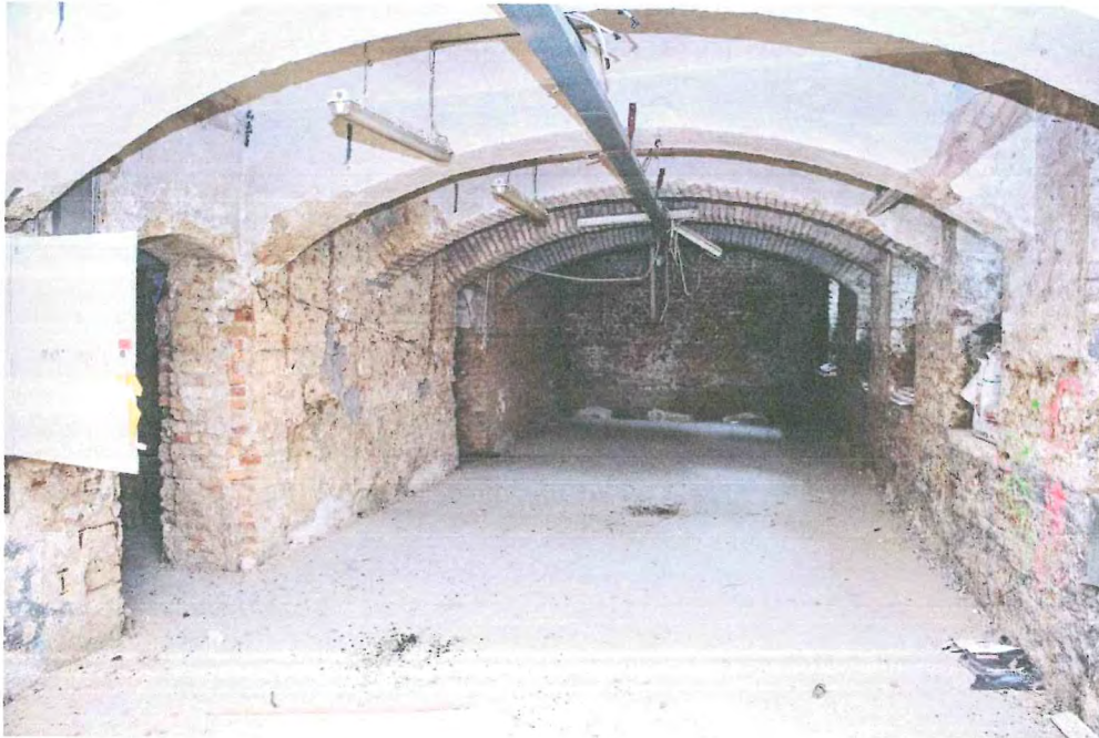
Abbildung 49: Kellerraum mit Bodenplatte
