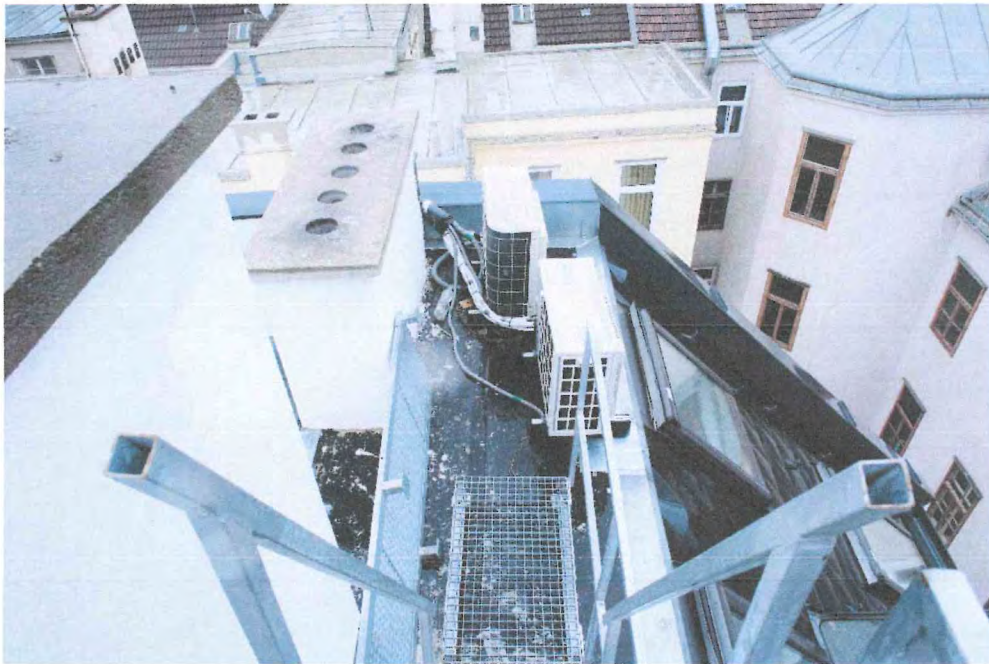
Abbildung 59: Dach, Kamine, Hoftrakt
