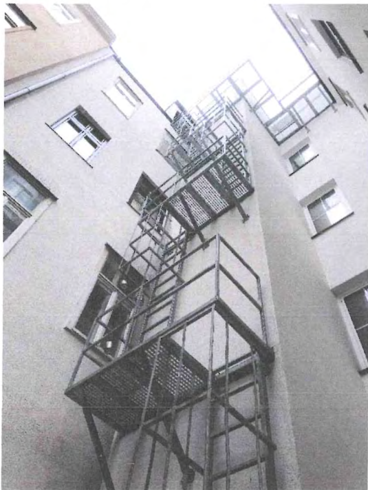
Abbildung 21: Liftschacht mit davor liegendem 2. Rettungsweg, Innenhof Zugang
