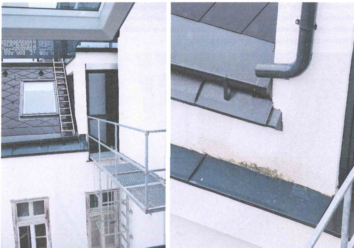
Abbildung 1: Fassade Hofbereich - die Fassade wurde mittlerweile fertiggestellt
