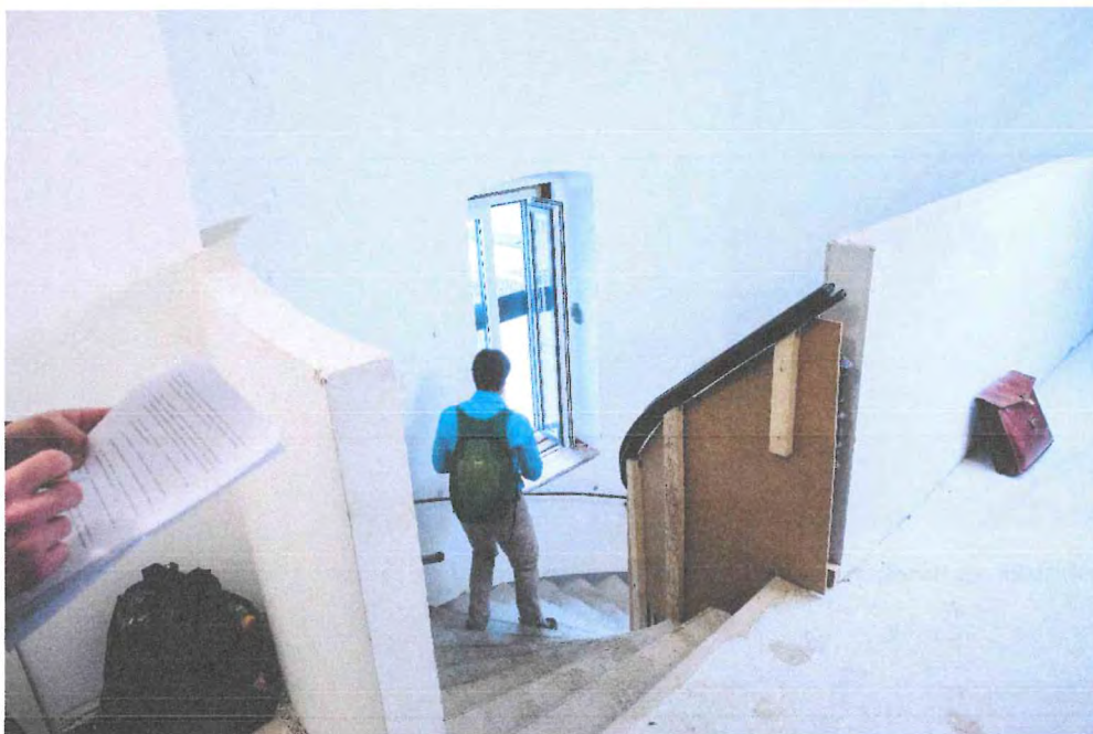
Abbildung 16: Mit Holzwerkstoffen "aufgesattelter" Treppenlauf, Brüstungsmauer
