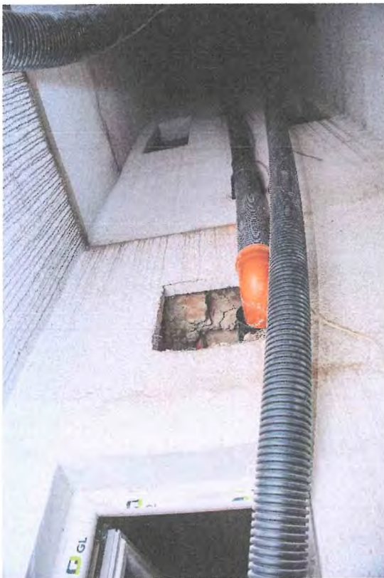
Abbildung 58: ehem. Lichthof - nun als Schacht genutzt
