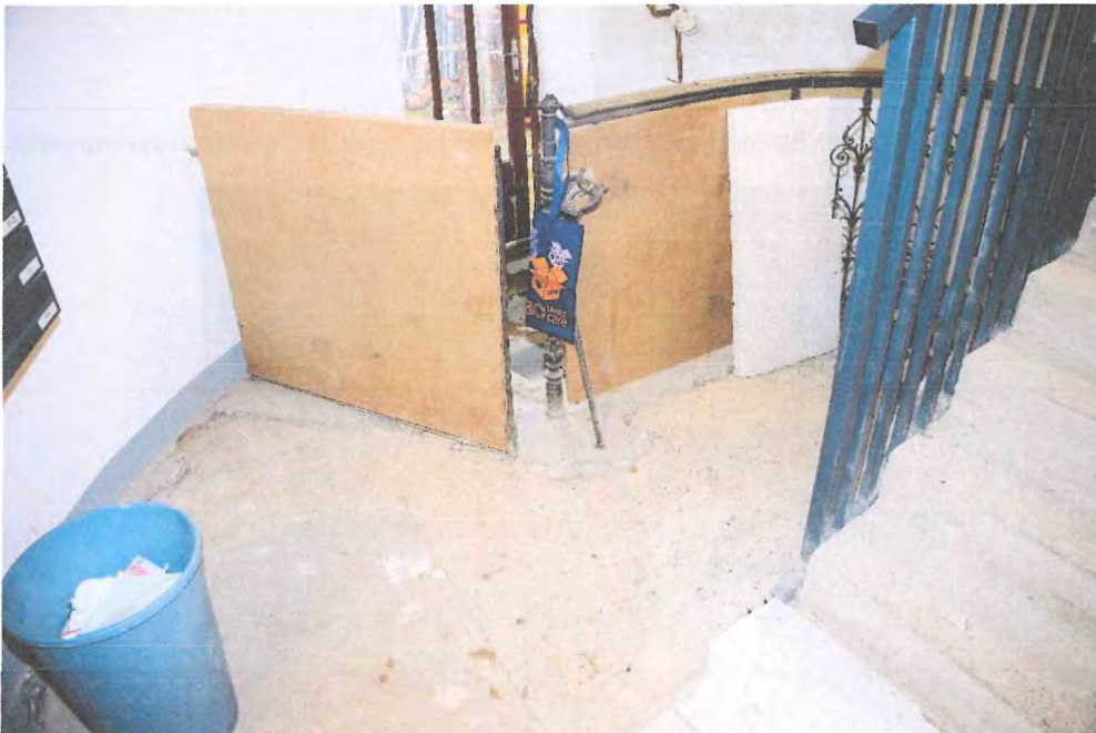
Abbildung 48: Abgang in den Keller
