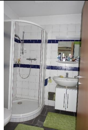
Bad 2: Boden: Fliesen; Wände: Fliesen türstockhoch; restliche Wände und Decke: verputzt und gemalt; Sanitärausstattung: 1 Hänge-WC mit Unterflurspülkasten, 1 Waschbecken, 1 Eckrunddusche mit Duschtrennwand; 1 Elektrowarmwasserspeicher, 1 Waschmaschinenanschluss;
