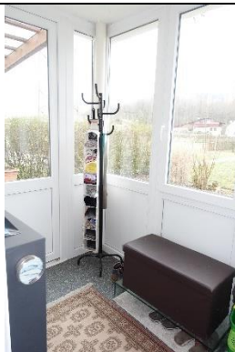
Windfang 2: Boden: Kunststoffbelag; Wände und Decke: verputzt und gemalt; Außenwände: Kunststoffelemente mit 2-Scheiben-Isolierverglasung;
