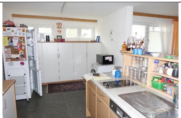
Küche/Essraum: Boden: Kunststoffbelag; Wände und Decke: verputzt und gemalt;
