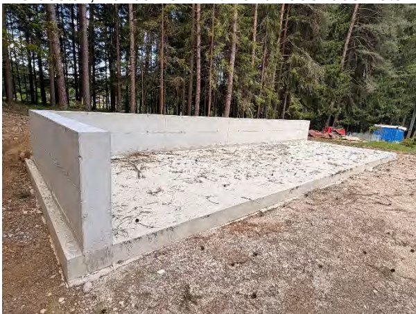
Pferdestall; Fundament mit Randmauer aus Beton
