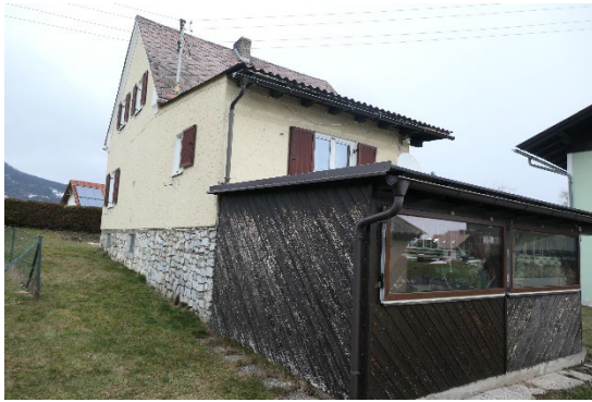
Ansicht von Südwesten mit Carport
