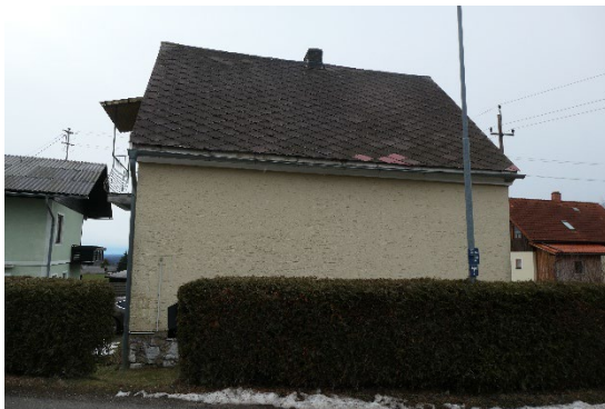
Wohnhaus, Ansicht von der Straße
