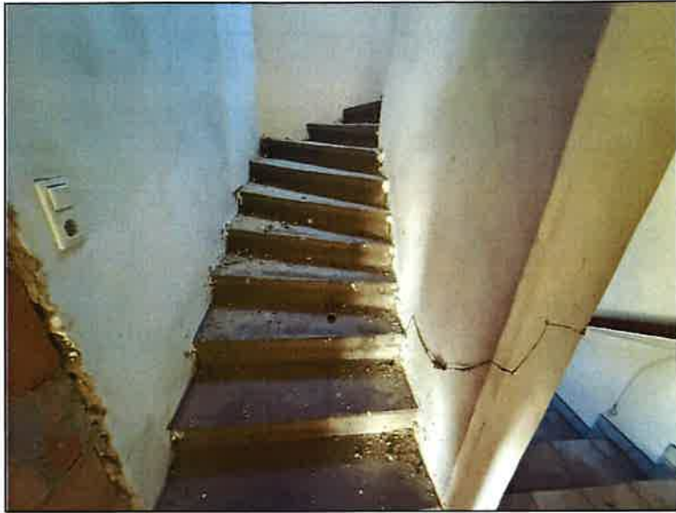
Über Betonstiege ins Dachgeschoss DACHGESCHOSS
