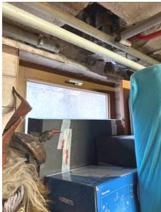
Gegenüberliegend vom Kellerraum Top 1 besteht der Heizraum, in dem ein Fliesenboden verlegt ist. Wände und Decke sind verputzt. Es verlaufen verschiedene Leitungen Aufputz. Die Deckenleitungen sind isoliert, die anderen Leitungen verlaufen ohne Isolierung.
