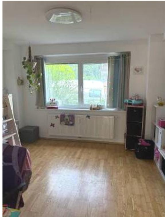
Nordseitig ist ein Fenster mit einer seitlichen Fixverglasung und einem öffenbaren Flügel eingebaut. Unterhalb besteht eine kunststoffbeschichtete Fensterbank und unterhalb an der Wand ist ein Heizungs radiator montiert. In diesem Zimmer besteht im abgeschrägten Bereich eine Öffnung als Erschließungsmöglichkeit für das Ofenrohr.
