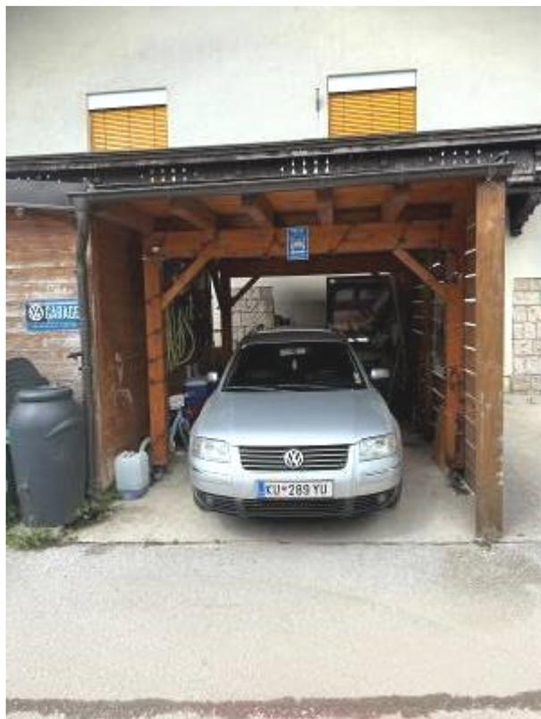
Außen ist dieses umlaufend mit einem beschichteten Blech abgeschlossen. Ostseitig besteht eine Dachrinne mit Abflussrohr, das offen zum Boden verläuft.
