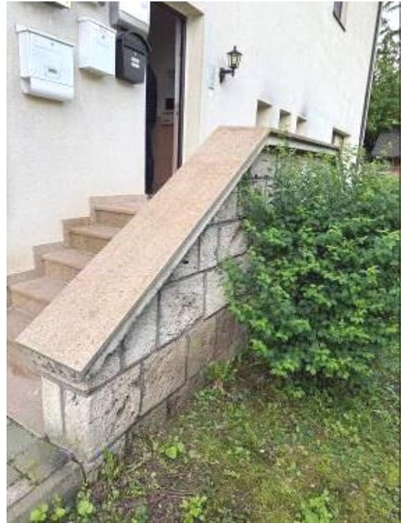
Der Verputz weist verschiedene Verfärbungen auf und teilweise bestehen leichte Putzbeschädigungen. Die Brüstungsmauer ist zu niedrig und entspricht nicht der Höhe, die als Absturzsicherung nötig ist.
