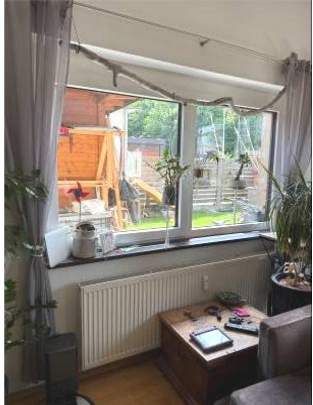
Anschließend besteht ein Schiebelelement mit seitlicher Fixverglasung auf die Terrasse und ostseitig ein Fenster mit Fixverglasung und einem Flügel zum Öffnen. Unter dem südseitigen Fenster ist ein Heizungs radiator eingebaut. Wände und Decke sind verputzt. Zwischen Wohn- und Küchenbereich verläuft an der Decke ein Unterzug der südseitig auf einem Mauerpfeiler aufsitzt.
