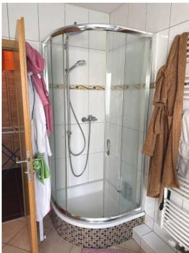
Die Dusche hat eine Duschtasse mit Duschabtrennung, deren Griffe teilweise lose sind, eine Handbrause und eine Überkopfbrause. Die Duschtasse ist im Außenbereich mit kleinformatigen Mosaikfliesen verkleidet.
