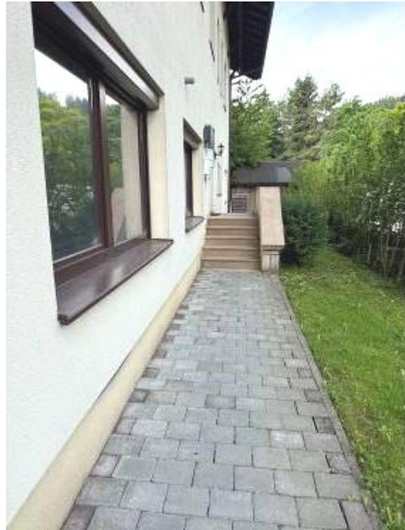
Anschließend gelangt man zu einer Stiege mit vier Stufen und einem Podest zur Hauseingangstüre. Dieser Bereich wird durch das Vordach des Hauses überragt. Im Vordachbereich sind mit freiem Auge Verfärbungen und auch Beschädigungen zu sehen. Die Ursache dafür kann nicht festgestellt werden.
