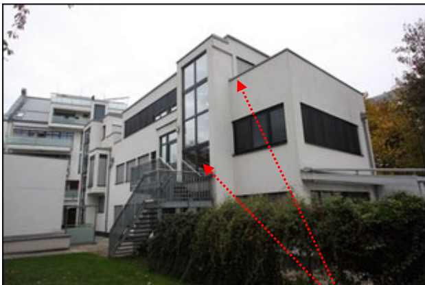
Abb.5 Ansicht Hofgebäude entlang der südlichen Grundgrenze, westl. Gebäudeteil: Lage Wohnung Einheit 13 Top H04 (1./2.OG)
