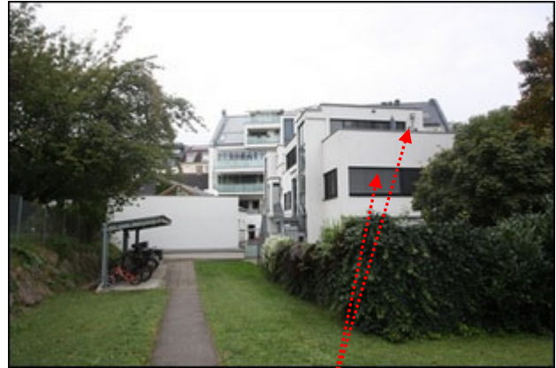
Abb.16 Ansicht Liegenschaft, Garten (Teilbereich TG, begrünt) Lage Wohnung Einheit 13 Top H04 (1./2.OG), vgl. Abb.5, 6
