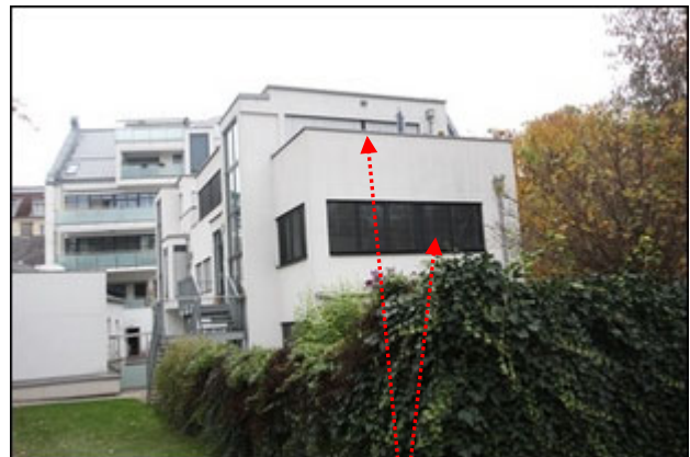
Abb.18 Ansicht Hofgebäude, westlicher Gebäudeteil Lage Wohnung Einheit 13 Top H04 (1./2.OG)
