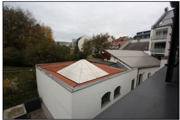
Abb.38 Ansicht Aussicht von einem nordseitigen Fenster (2.OG) auf den Anbau entlang der nördlichen Grundgrenze (Restaurant)
