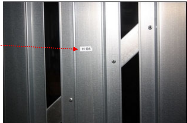
Abb.44 Ansicht Detail zu Abb.43, Kellerabteil Nr. H04
