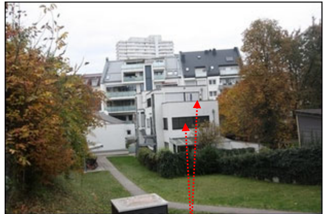
Abb.8 Ansicht Liegenschaft (von Westen aus) Lage Wohnung Einheit 13 Top H04 (1./2.OG), vgl. Abb.5, 6
