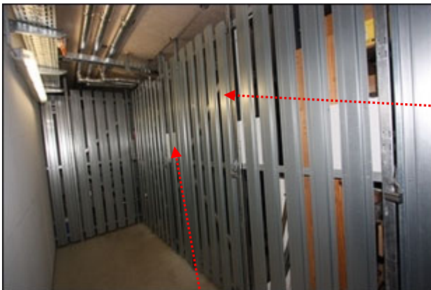
Abb.43 Ansicht Bereich Kellerabteile (zugehöriges) Kellerabteil Top H04
