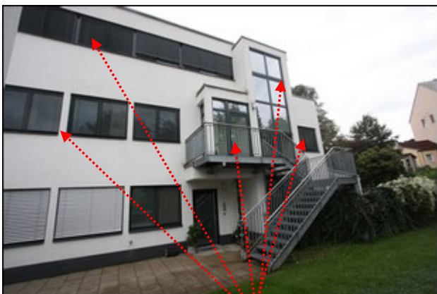
Abb.19 Ansicht Hofgebäude, westlicher Teilgebäudeteil Lage Wohnung Einheit 13 Top H04 (1./2.OG) Erschließung über Außenstiege
