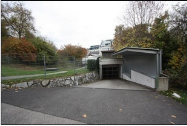
Abb.47 Ansicht Erschließung Tiefgarage (vgl. Abb.9-11)
