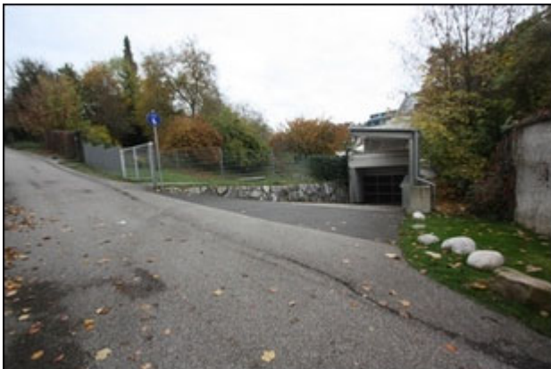
Abb.11 Ansicht Liegenschaft Westseite, Zufahrt Tiefgarage (TG)
