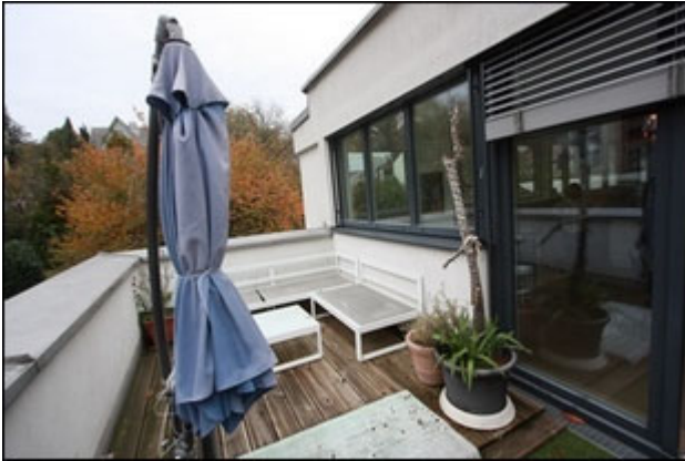
Abb.35 Ansicht Dachterrasse West (vgl.Abb.18, 2.OG)
