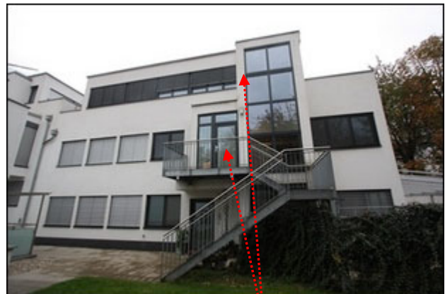
Abb.6 Ansicht Außenstiege, Wohnungseingang/1.OG Lage Wohnung Einheit 13 Top H04 (1./2.OG)
