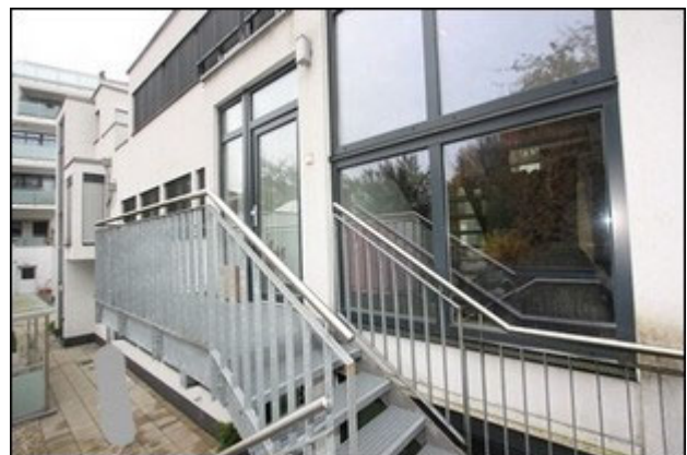
Abb.20 Ansicht Außenstiege, Wohnungseingang (1.OG)
