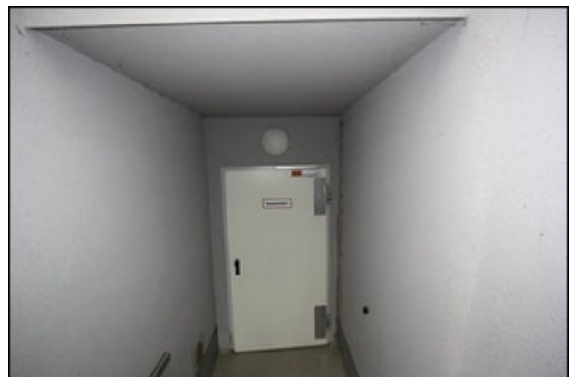
Abb.46 Ansicht Eingang Tiefgarage
