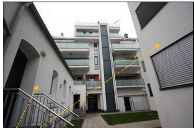
Abb.4 Ansicht Gebäude Hauptstr. 63 (Vorderhaus, Hofseite) links: Anbau (Teilfläche Restaurant/u.a. eingehauster Gastgarten) rechts: Hofgebäude, östlicher Gebäudeteil (Wohnungen) Lage Wohnung Einheit 13 Top H04, siehe Hofgebäude (Abb.5, 6)
