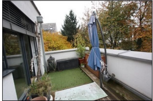
Abb.36 Ansicht Dachterrasse West (vgl.Abb.18, 2.OG)
