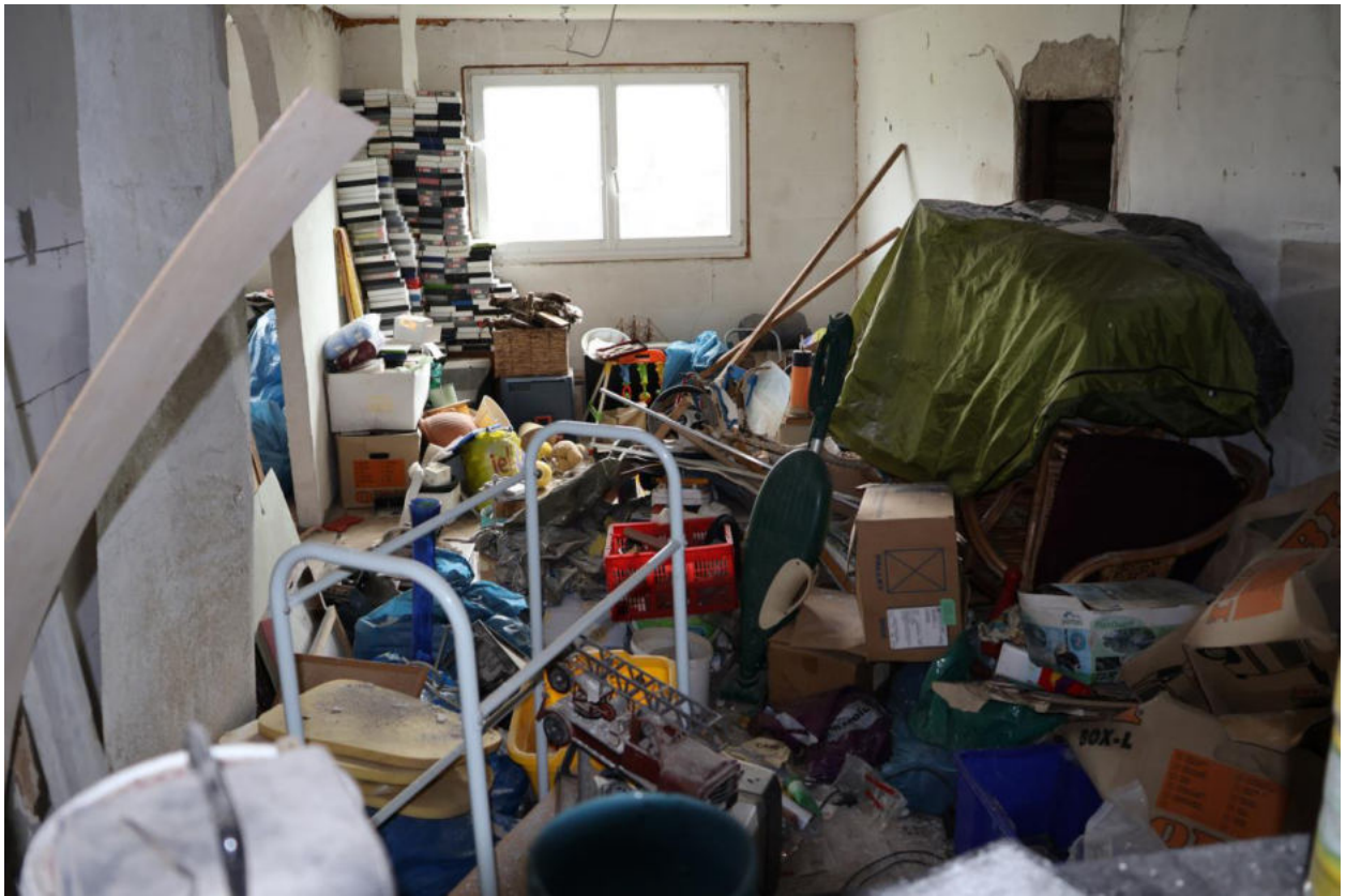
Bild 31 Sperrmüllablagung Dachboden bei der östlichen Gaube
