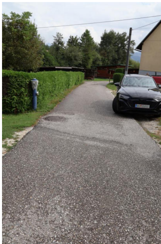
Bild 40 Wasserweg Zufahrtsbereich Richtung Osten
