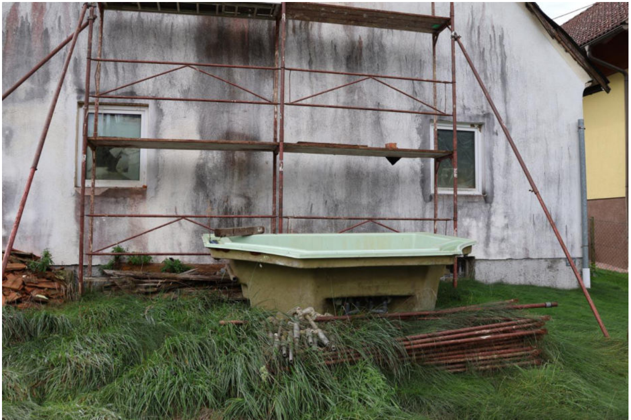
Bild 3 Gebäudeansicht Nordfassade mit Gerüst und Pool
