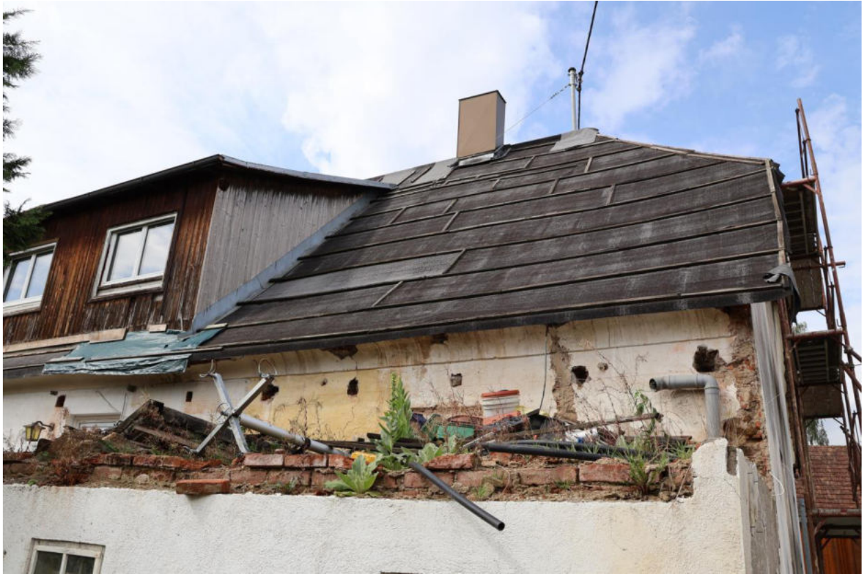
Bild 7 Dachfläche mit Gaube Nordostecke samt dem EG-Dachabbruch vom Zubau
