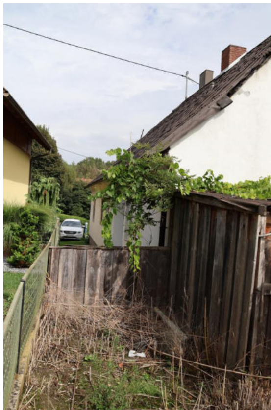
Bild 16 Einfriedung zum westlichen Nachbargrundstück
