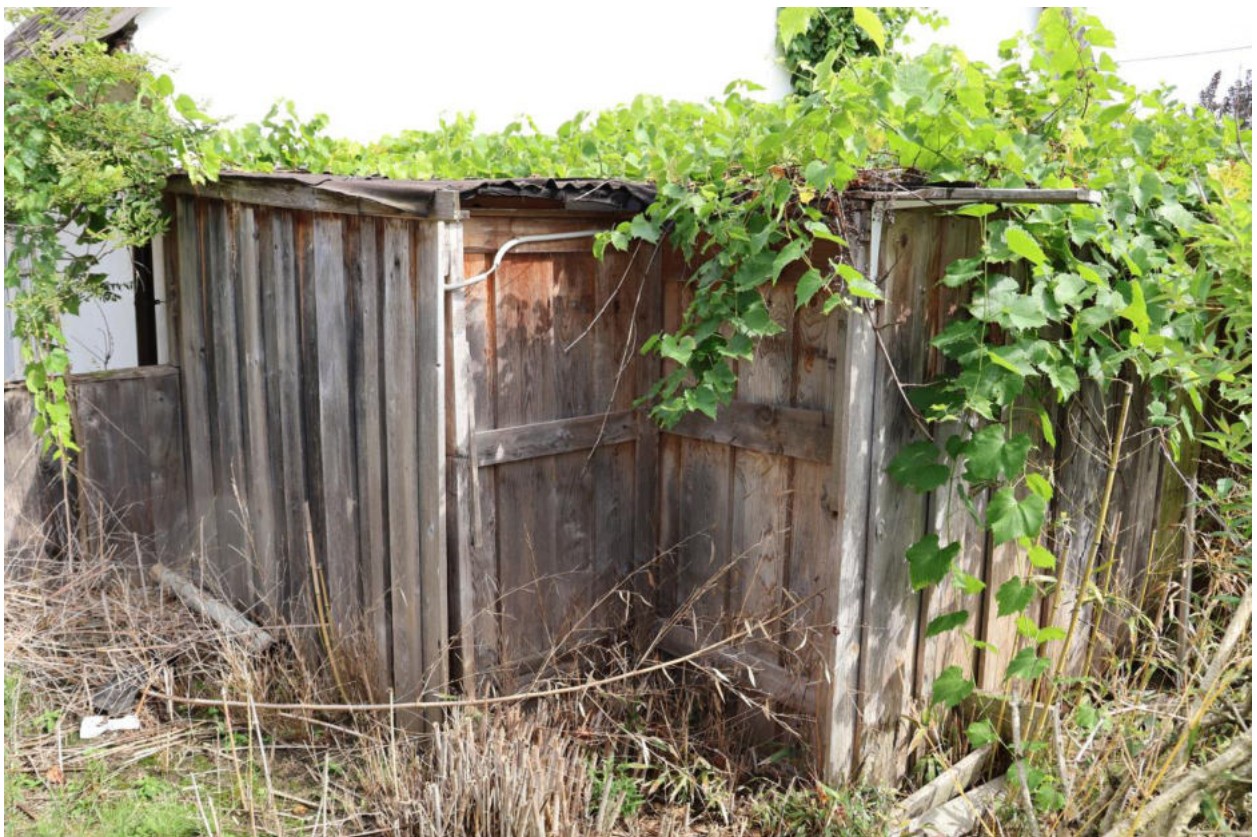
Bild 14 Holzverschlag an der Südseite
