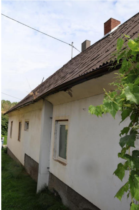
Bild 11 Westseite mit Bitumen-Wellplatten als Dacheindeckung
