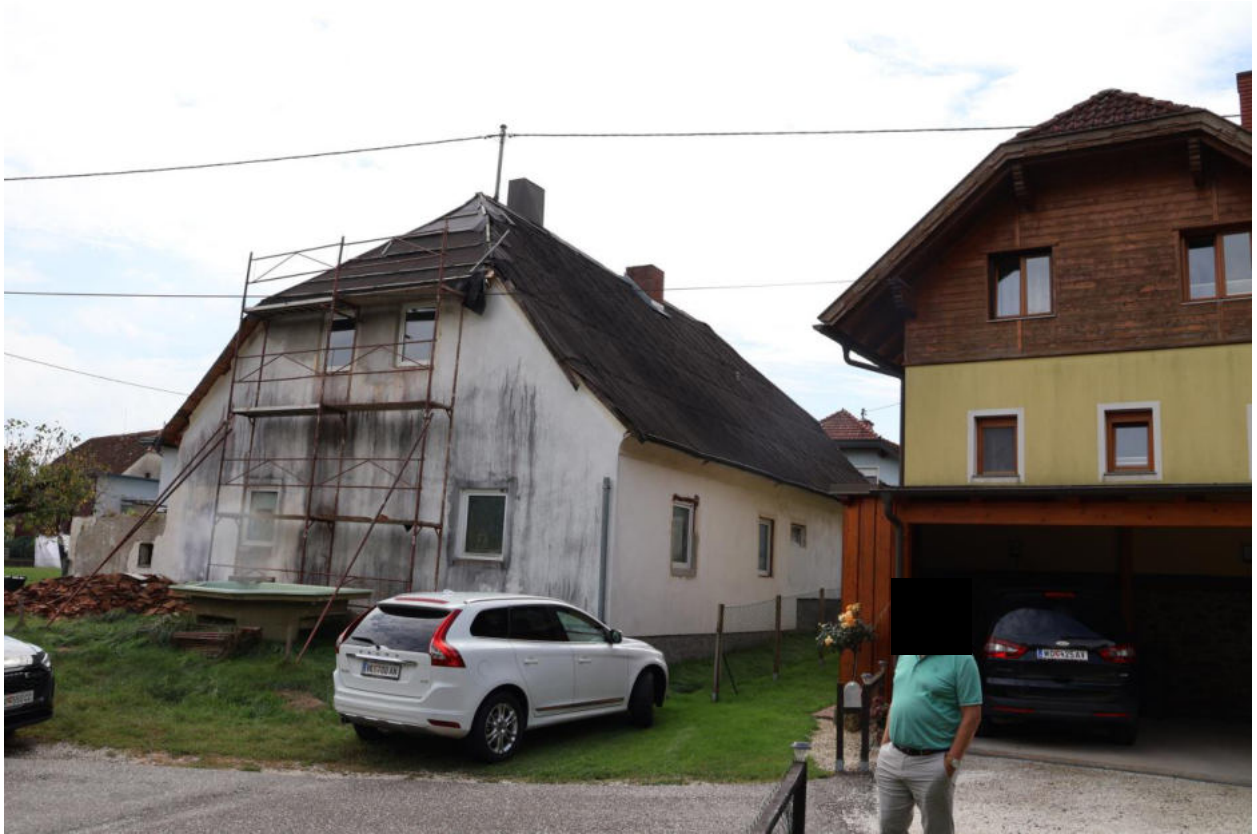
Bild 41 Nachbarobjekt an der Westseite mit Kelag-Freileitung zur gemeinsamen Stromversorgung
