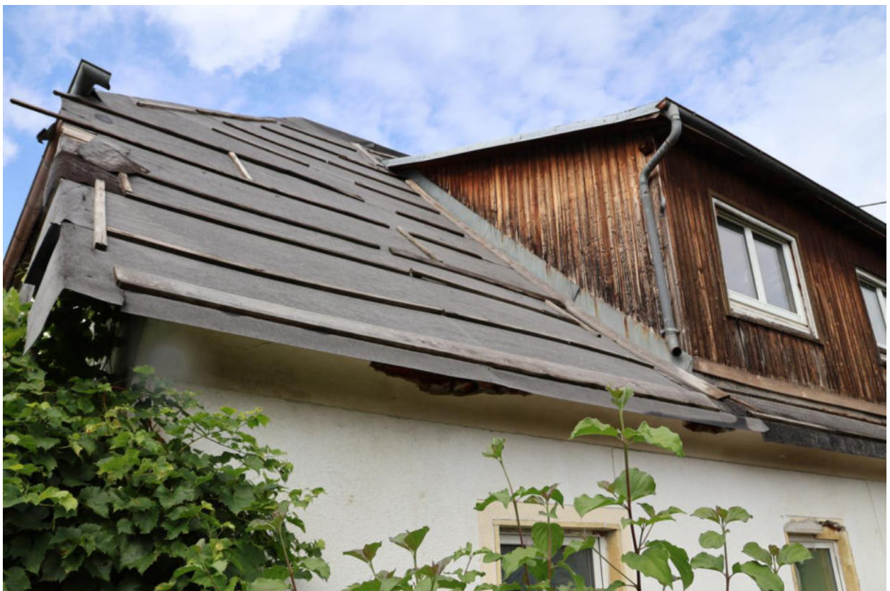
Bild 6 Dachfläche mit Gaube an der Ostseite
