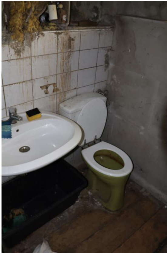
Bild 25 EG WC / Bad
