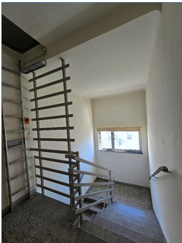
Stiegenhaus im 7. OG
