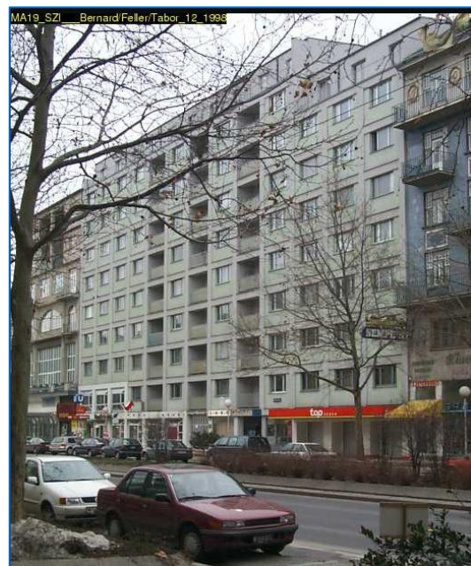
Straßenfassade (MA 19 Schnellinventarisierung 12/1998)
